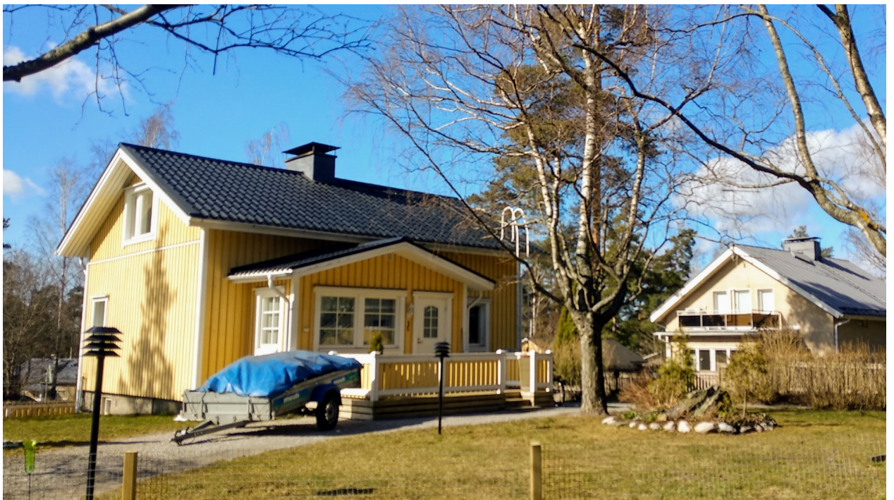
Bild 3. Trollbergsvägen 1. Brädfodring, takmaterial och fönster har bytts ut och bostaden har byggts till år 2002.
