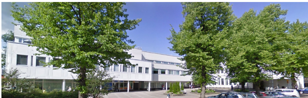
Den sr-märkta, av Alvar Aalto planerade byggnaden på tomterna 284 och 286.
