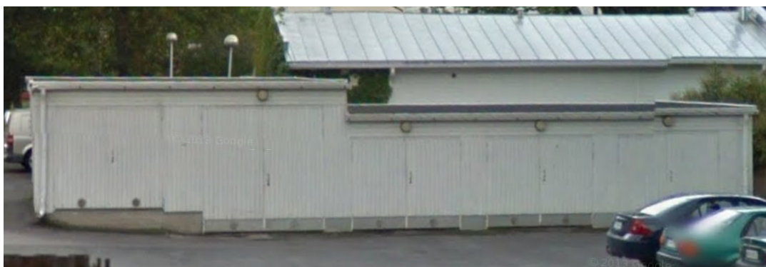
Garage- och servicebyggnaden på tomt 285.
