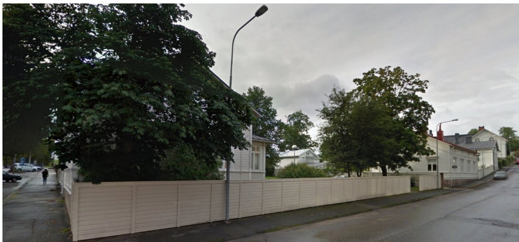
Byggnaderna mot Sigfrid Aroni gata.
