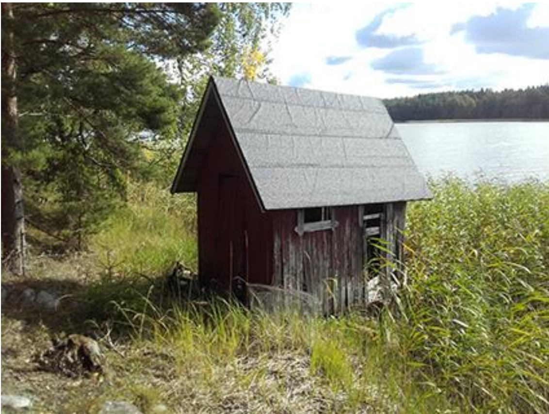
Bild 4. Strandskjulet är ett landbaserat båthus.
