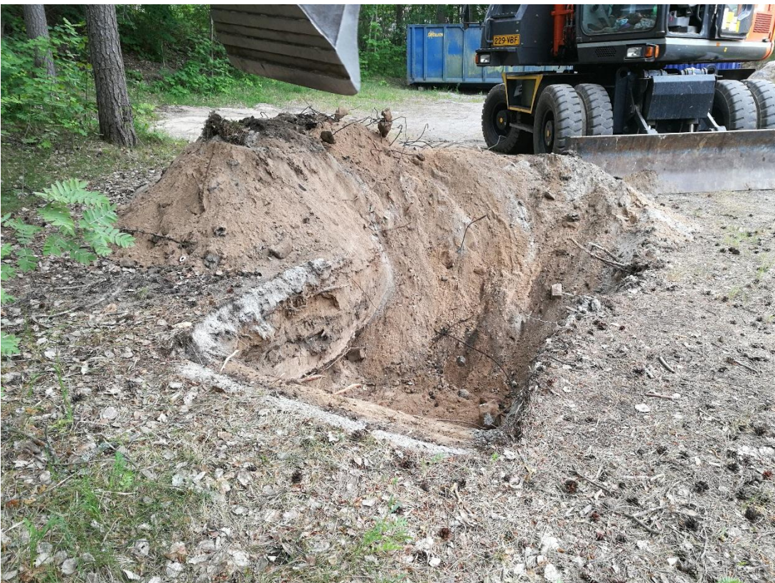
Kuva 4. Tutkimuspiste SW21. Tutkimuspisteessä todettiin runsaasti raudoituksrautoja ja hieman tiiltä.
