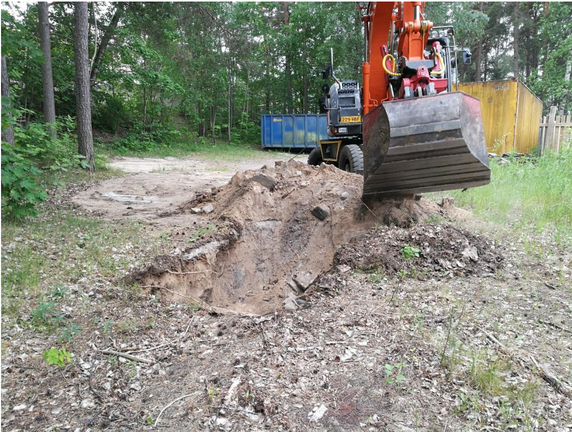
Kuva 5. Tutkimuspiste SW22. Tutkimuspisteessä SW22 havaittiin betonilaatta.
