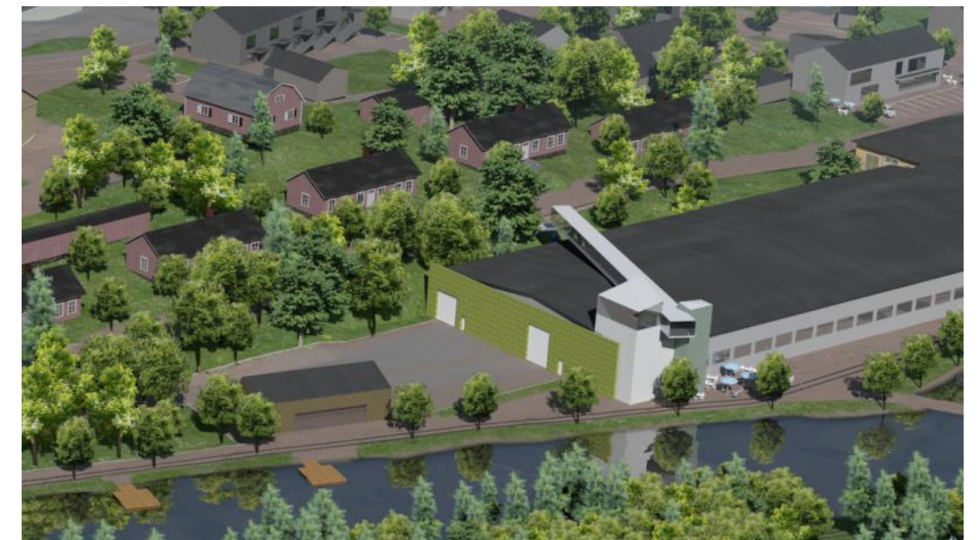
Tehtaan länsipäädyn ympäristöä elävöittävät uudet toiminnot ja kulkuyhteydet.
