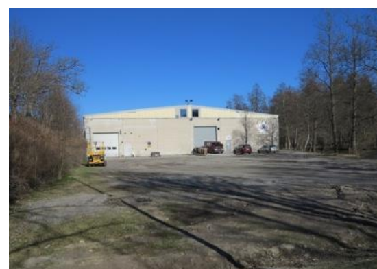
Vasemmalla kuvia nykytilanteesta. Vasemmalla näkymä Peltoraittia itään, oikealla konepajan 1980-luvun laajennuksen pääty jonka edustalla on lastauspiha.
