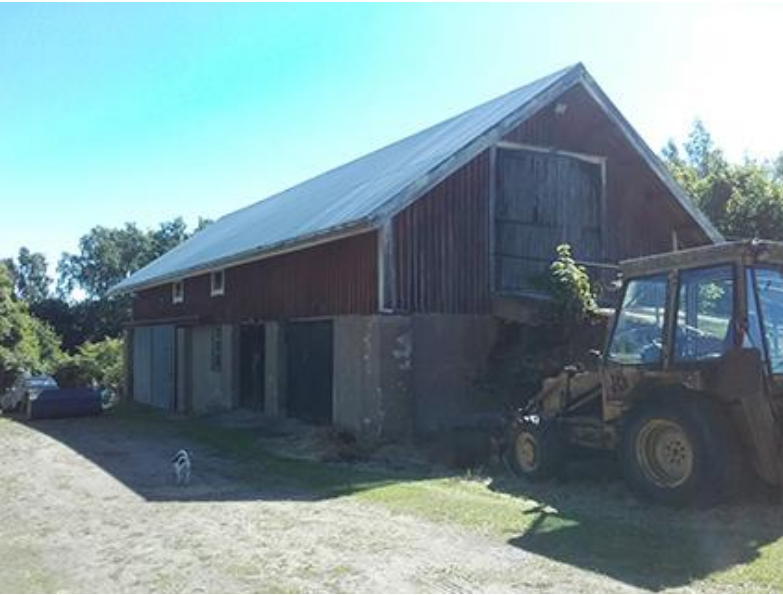
10. Verkstaden. Det gamla svinhuset (11) är fastbyggt i verkstaden på dess bakre sida.
