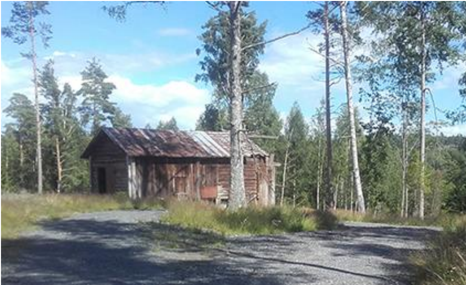
Den gamla smedjan och rian i norr bevaras som ekonomibyggnad.
