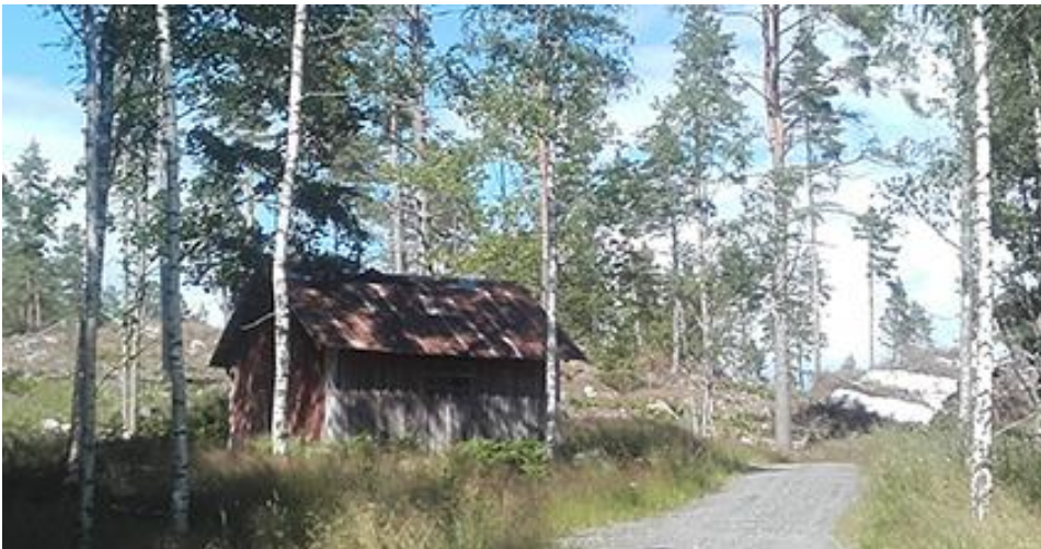
Ekonomibyggnad som rivs.
