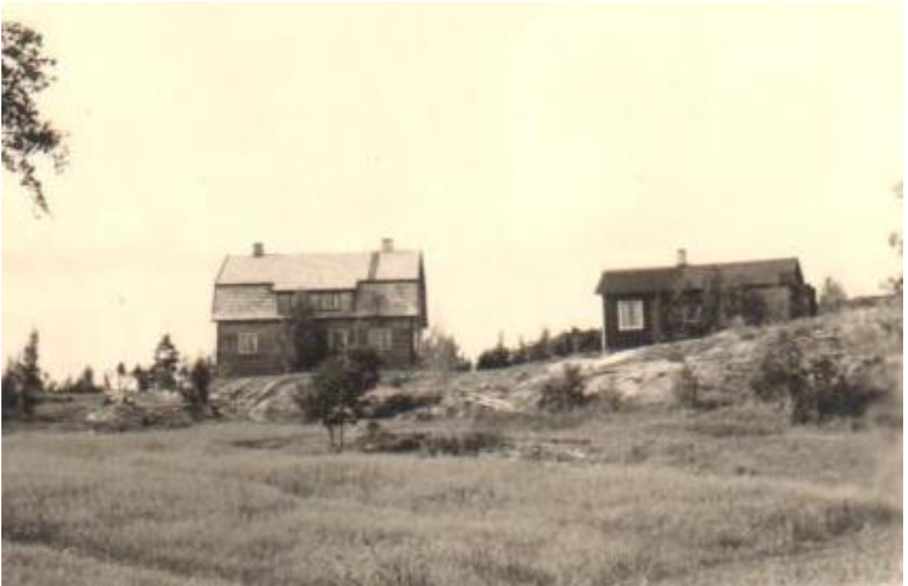
Bild 4. De nybyggda bostadshusen efter kriget, bild norrifrån.
