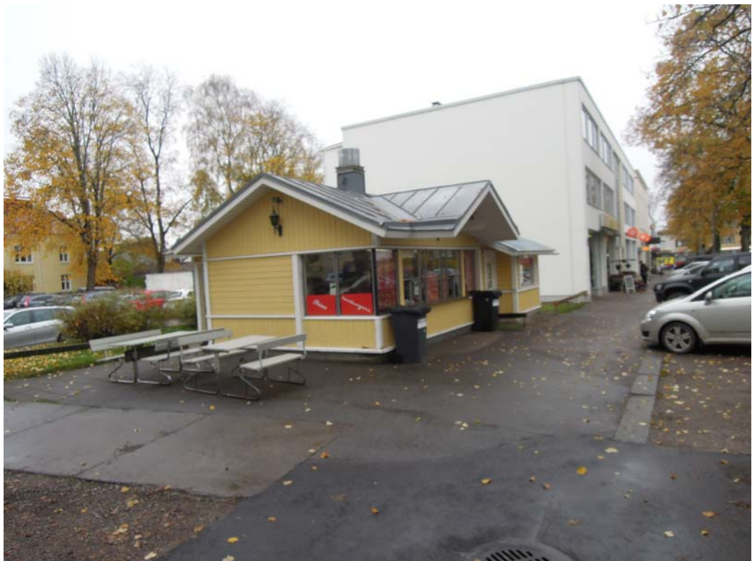
Näkymä tontilla sijaitsevasta kioskirakennuksesta ja vuonna 1971 valmistuneesta rakennuksesta, joko rajautuu suoraan kiinni kaava-alueen reunaan.
