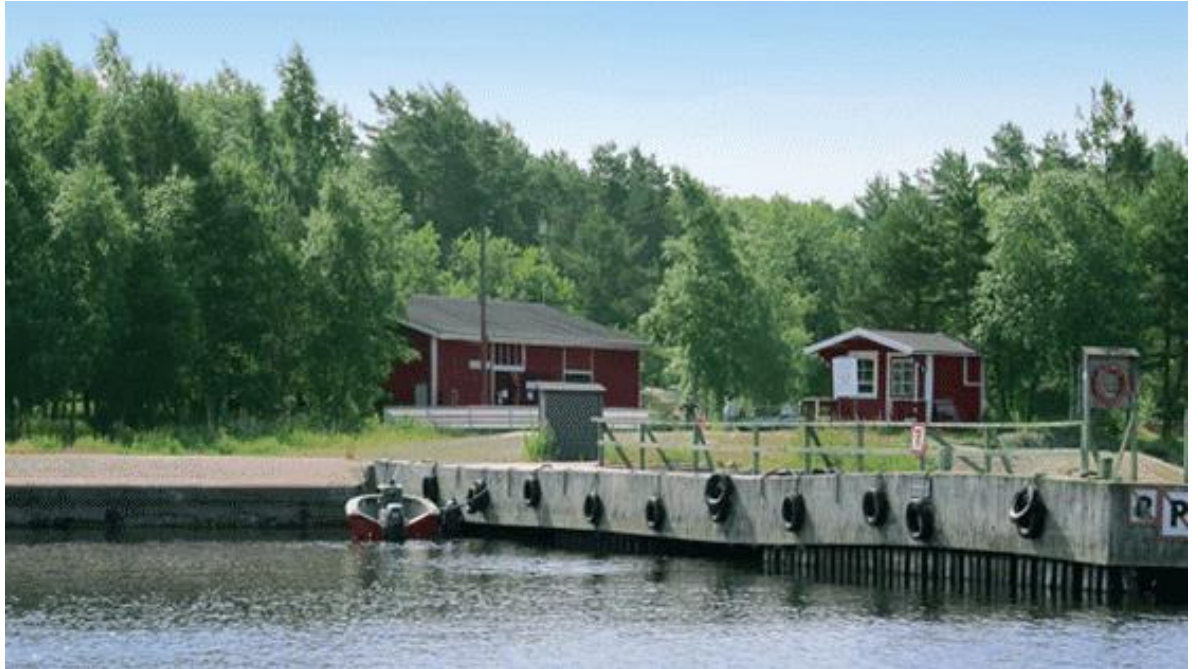
Bild 2. Byggnader vid Jussarö båthamn. (Bild Lotta Söderlund, www.jussaro.net )
