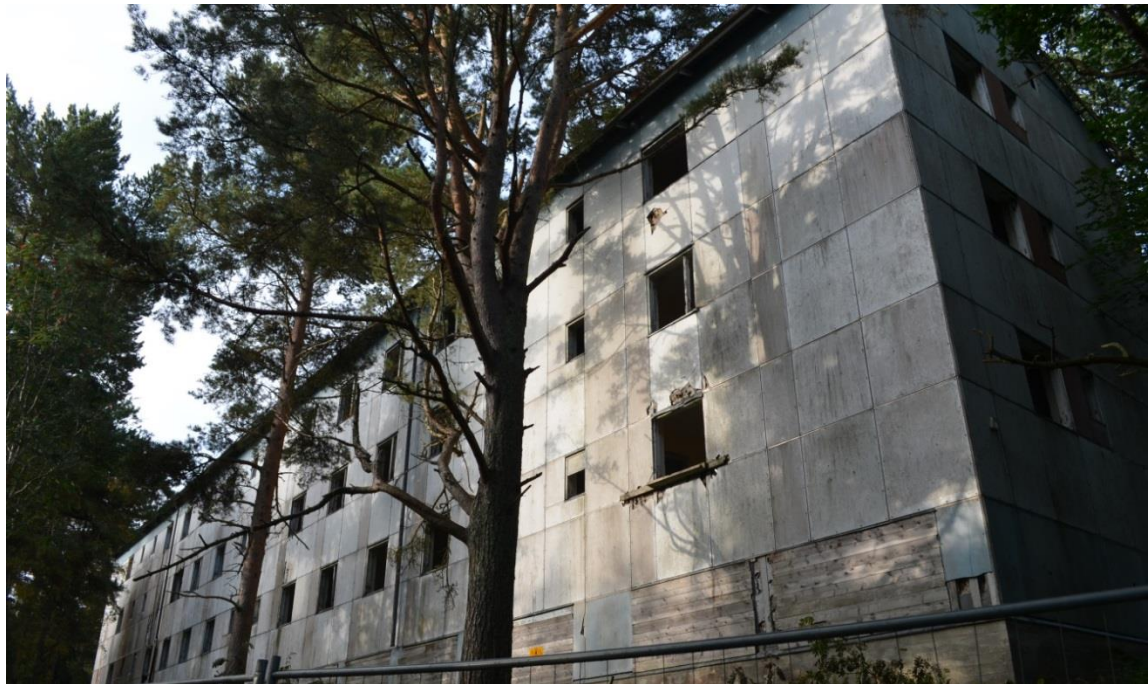
Bild 11. På Jussarö byggdes bostadsbyggnader för gruvarbetarna på 1950-talet. Byggnaderna är i nuläget övergivna och isolerade med stängsel. (Bild FCG 2014)
