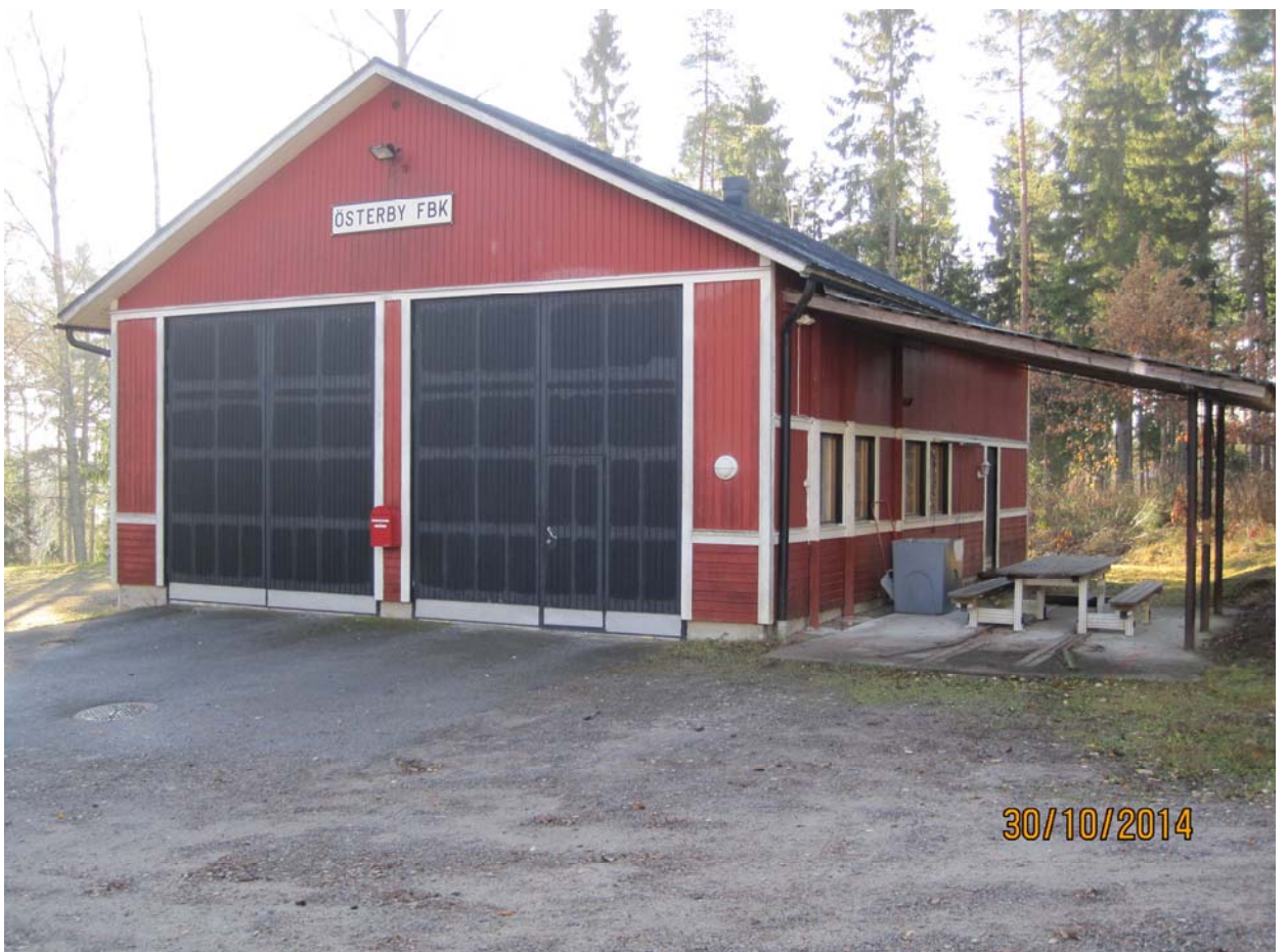
Österbyn vapaapalokunnan paloasema
