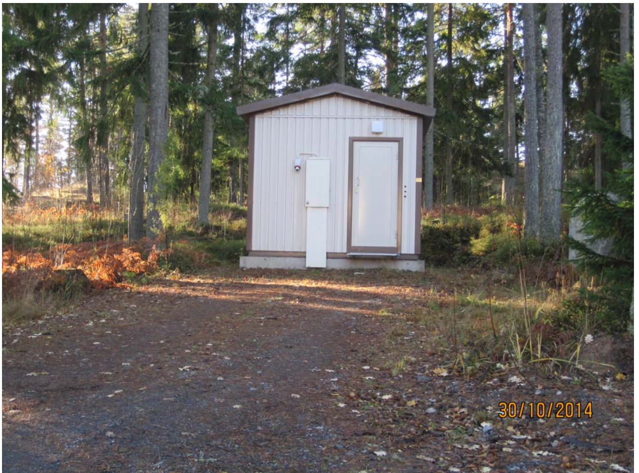
Karjaan puhelin Oy:n tekninen tila
