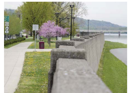
Verhoilematon tulvamuuri, Yhdysvallat
