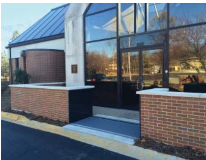
Tiiliverhoiltu tulvamuuri, Yhdysvallat
