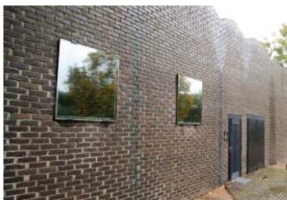
Moderna fönster i murliknande fasad. Ark. Sigurd Lewerentz.
