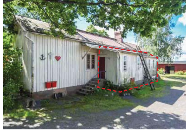
Bostadsbyggnaden från inre gård. Det är möjligt att ersätta ingångarna
