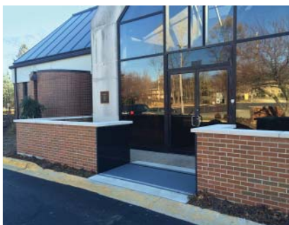
Översvämningssmur, täckt med tegel, USA
