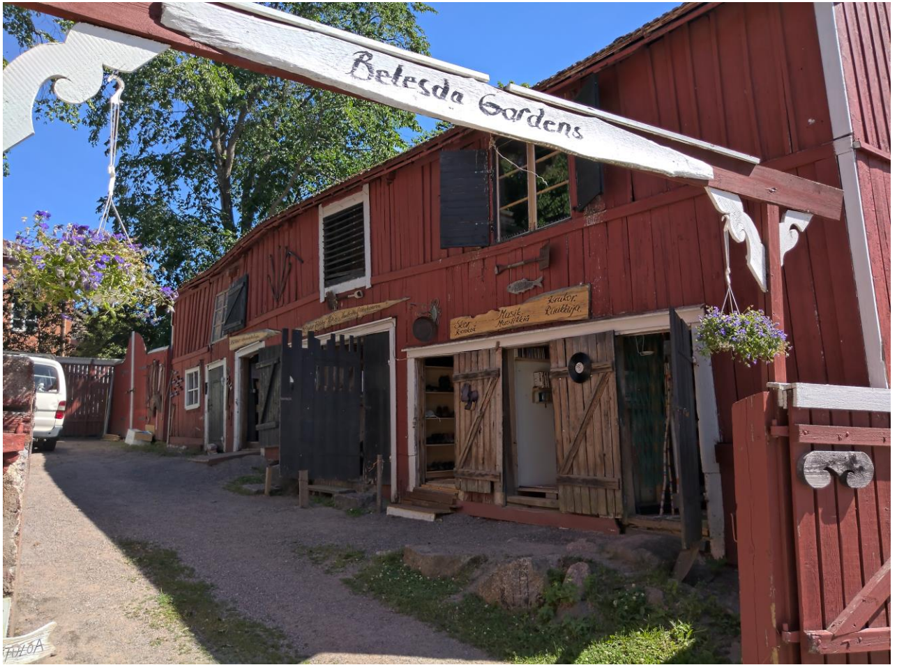
Kuva 13 korttelin 1031 sisäpihan talousrakennus
