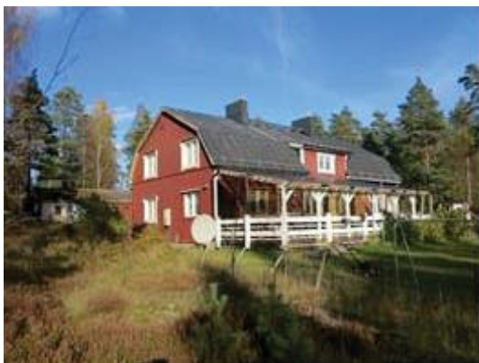
Kuva 12. Asuinrakennus Hangontien eteläpuolella vanhan Rannikotien risteyksessä. Kuva Kristina Karlsson 2015.
