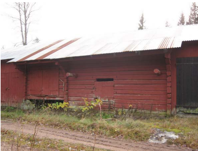
Piharakennuksen nro 4 keskiosa
