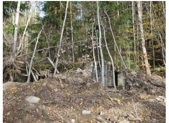
Betoniperustus osin maaläjityksen alla.
