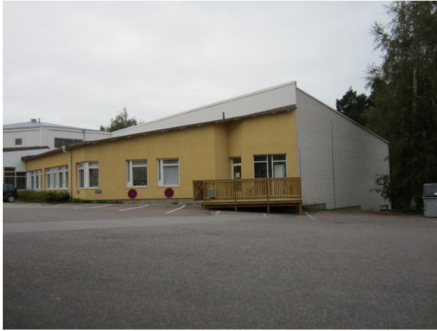
Uudisrakennus B3 kuvattuna idästä kesällä 2012. rakennuksen julkisivumateriaalit toistavat Hilding Ekelundin vaaleankeltaisen rappauksen ja kalkkihiekkatiilen vuorottelua.
