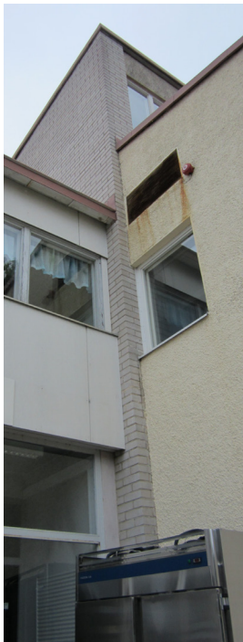
Samaan vaiheeseen (1963–65) kuuluvien kolmen erilaisen julkisivumateriaalin kohtaaminen.
