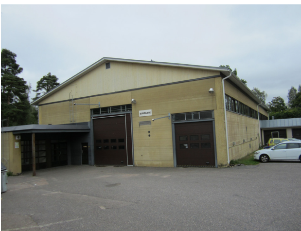
Auto- ja kuljetusosaston rakennus kuvattuna lounaasta kesällä 2012. Rakennuksen tasakatto korvattiin harjakatolla vuonna 2002.
