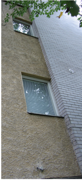
Kalkkihiekkatiilen ja rappauksen sauma laajennuksen B5 (1963–65) luoteisjulkisivussa. Samanlainen vuorottelu toistuu sittemmin vuosien 1985–87 laajennusosassa.
