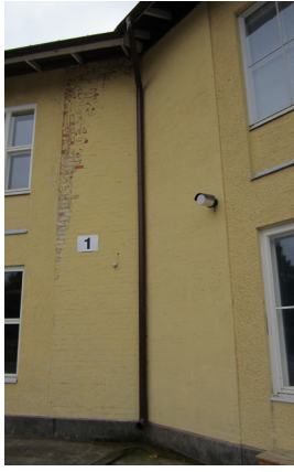
Verstassiiven (B1) ja vuosien 1958–59 laajennuksen sauma sisäpihan puolella.
