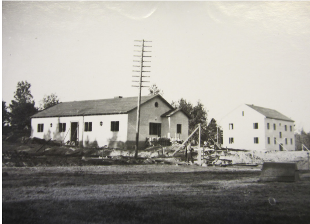
Esikunnan asuntola ja asuintalo rakenteilla kesällä 1942. Kuvattu Postimestarin- ja Esikunnankatujen (silloinen Lastenkodinkatu) risteyksestä kohti länttä. Paikallisarkisto Aresti, KMB 638:1978.
