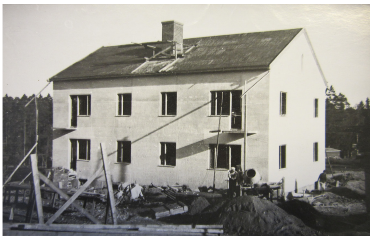
Asuntolan (A2) rakennustyöt käynnissä kesällä 1942. Paikallisarkisto Aresti, KMB 641:1978.
