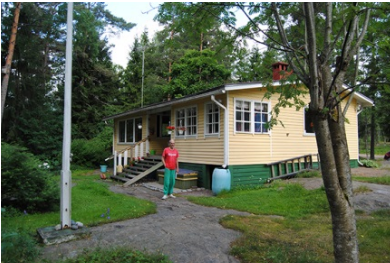
Kuva 12. Alkuperäinen veranta on rakennettu huonetilaksi. Varsinaista terassia ei ole.
