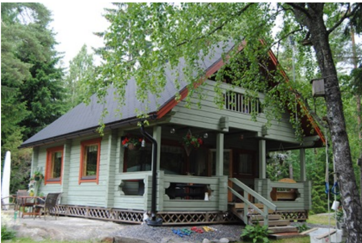
Kuva 19. Uusi hirsirakenteinen päärakennus parviratkaisulla. Veranta osana pääkehikkoa.
