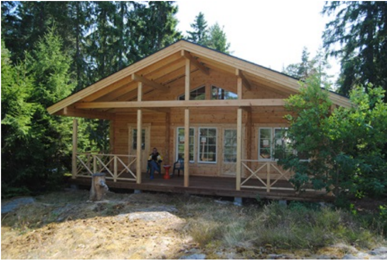
Kuva 20. Valmistumaisillaan oleva päärakennus.
