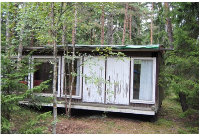
Kuva 16. Peruskorjaamaton päärakennus odottaa vuoroaan.
