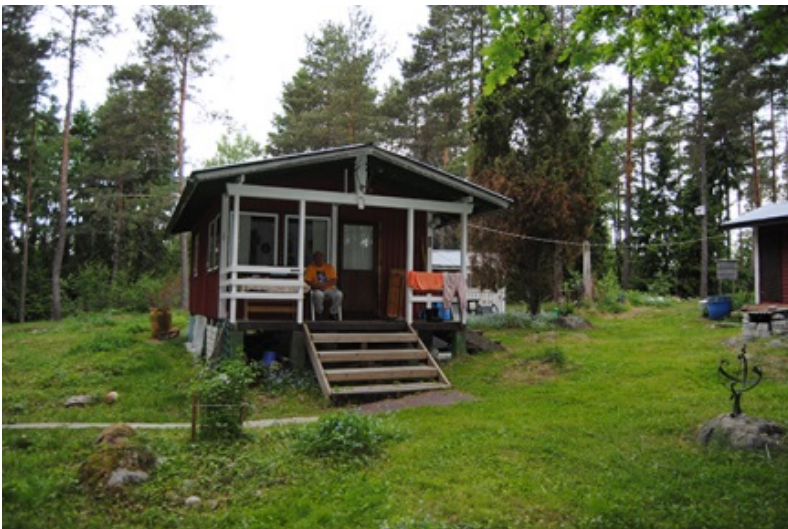
Kuva 10. Alkuperäiskokoinen päärakennus, jossa terassi on rakennettu päätyratkaisuna.
