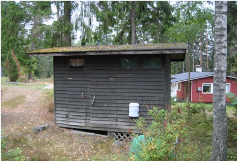
Bild 14. Ekonomibygggnad, i bakgrunden huvudbyggnaden.
