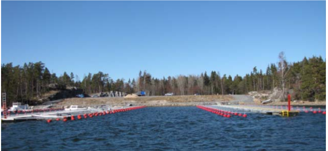
Kuva 2. Näkymä uloilmalta ponttonilaiturilta rakennuspaikalle.
