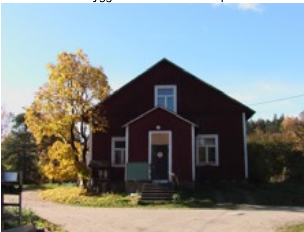
Byggnadens gavel mot nordost. Rakennuksen pääty koilliseen
