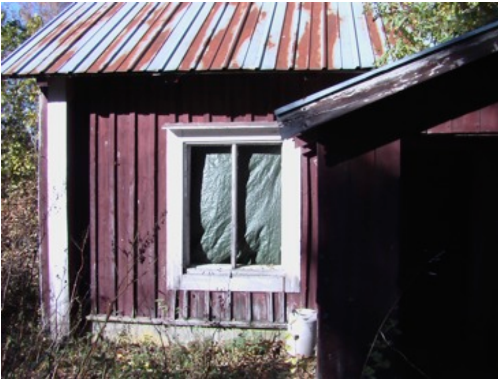
Gjuten betongsockel och öppna fönster. Betonivalusokkeli ja avoimet ikkunat.
