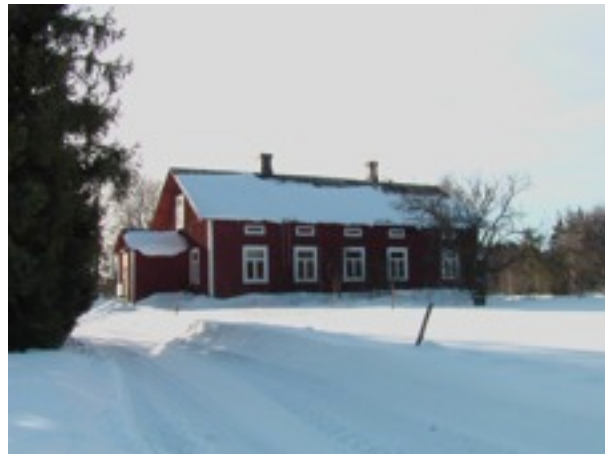
Byggnaden från nordväst. Rakennuksen sivu luoteeseen
