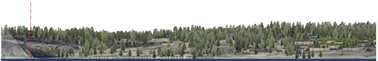
Kuva 34. Aluejulkisivu osa A.
