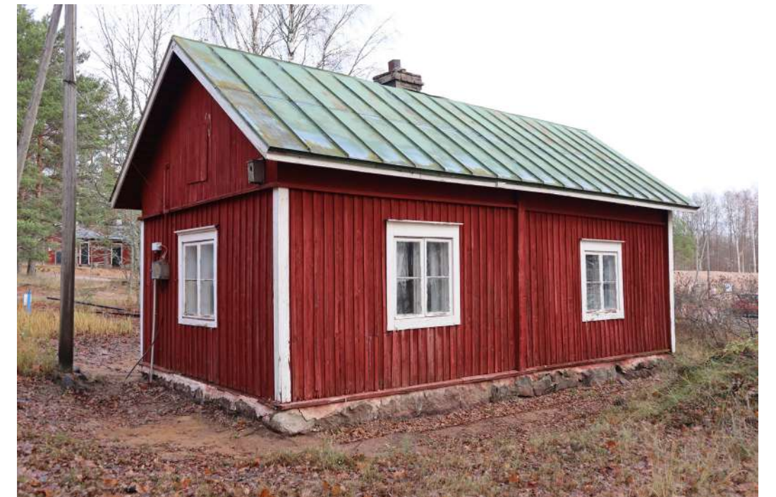
Rakennuksen matalan luonnonkivisokkelin ympäriltä on poistettu maata.
