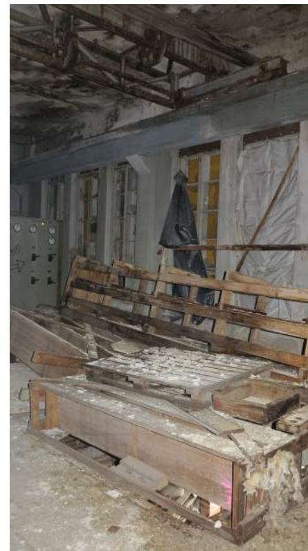
Näkymä rannanpuoleisesta sisätilasta, kuvassa näkyy mm. suoja- vanerien takana säilyneet vanhat puuikkunat.
