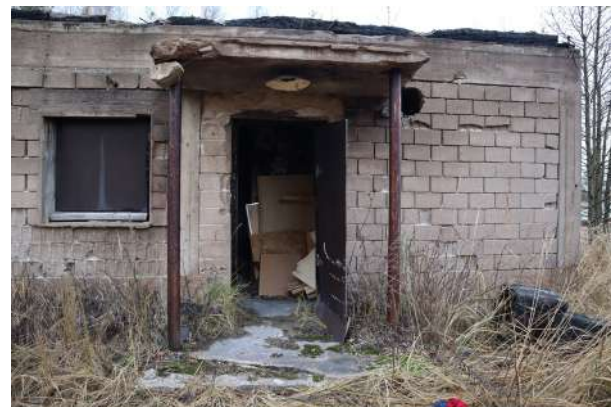
Vuonna 2005 tulipalossa tuhoutuneen saharakennuksen jäljiltä on säilynyt kalkkihiekkatilirakenteisen kellarikerroksen osa ja siihen liittyneen sisäänkäynnin teräskatos.
