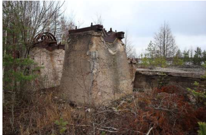
Sahan voimakamman jyrkät betoniperustukset
