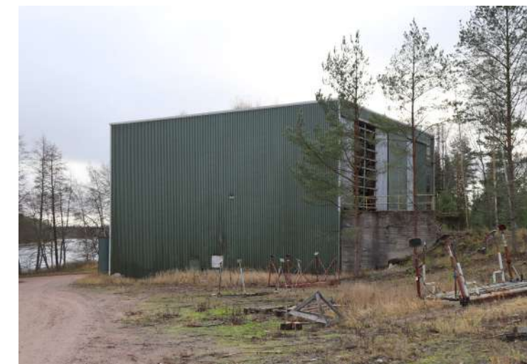
Vuonna 1979 valmistunut uusi lämpökeskus on betoni- ja teräs-runkoinen ja julkisivut on verhoiltu vihreällä teräspöimulevyllä.
