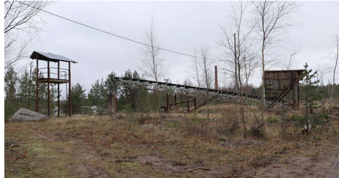
Entisen lautapihan alueella on siirrettävä kuljetin ja teräsrakenteinen pieni katettu torni.
