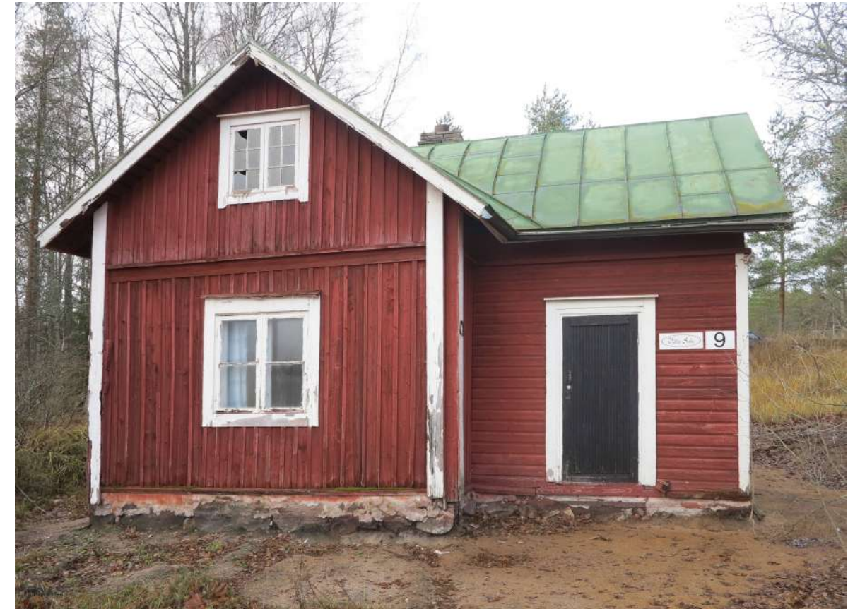
Rakennuksen julkisivuissa on vanha pystyrimavuoraus ja 4-ruutuiset ikkunat. Ullakon pieniruutuinen ikkuna saattaa olla vanhempi.
