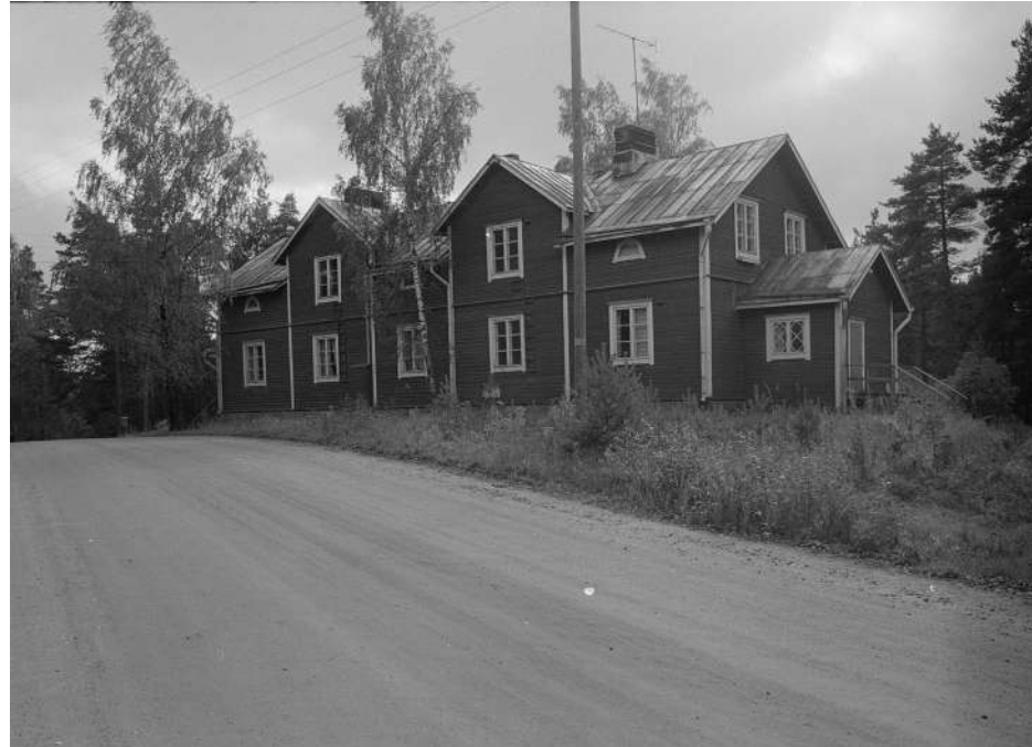
Banvillan vuonna 1987. Kuvassa näkyvät rakennuksen nyt peitetyt 6-ruutuiset ikkunat ja ullakon puolikaaren muotoiset lunetti-ikkunat sekä myöhemmin puretun pohjoispäädyn kuisti vinoristi-jakoisine ikkunoineen. SLS arkisto 1642_077 Skogby sågsamhälle, valokuvaaja Bertil Bonns.
