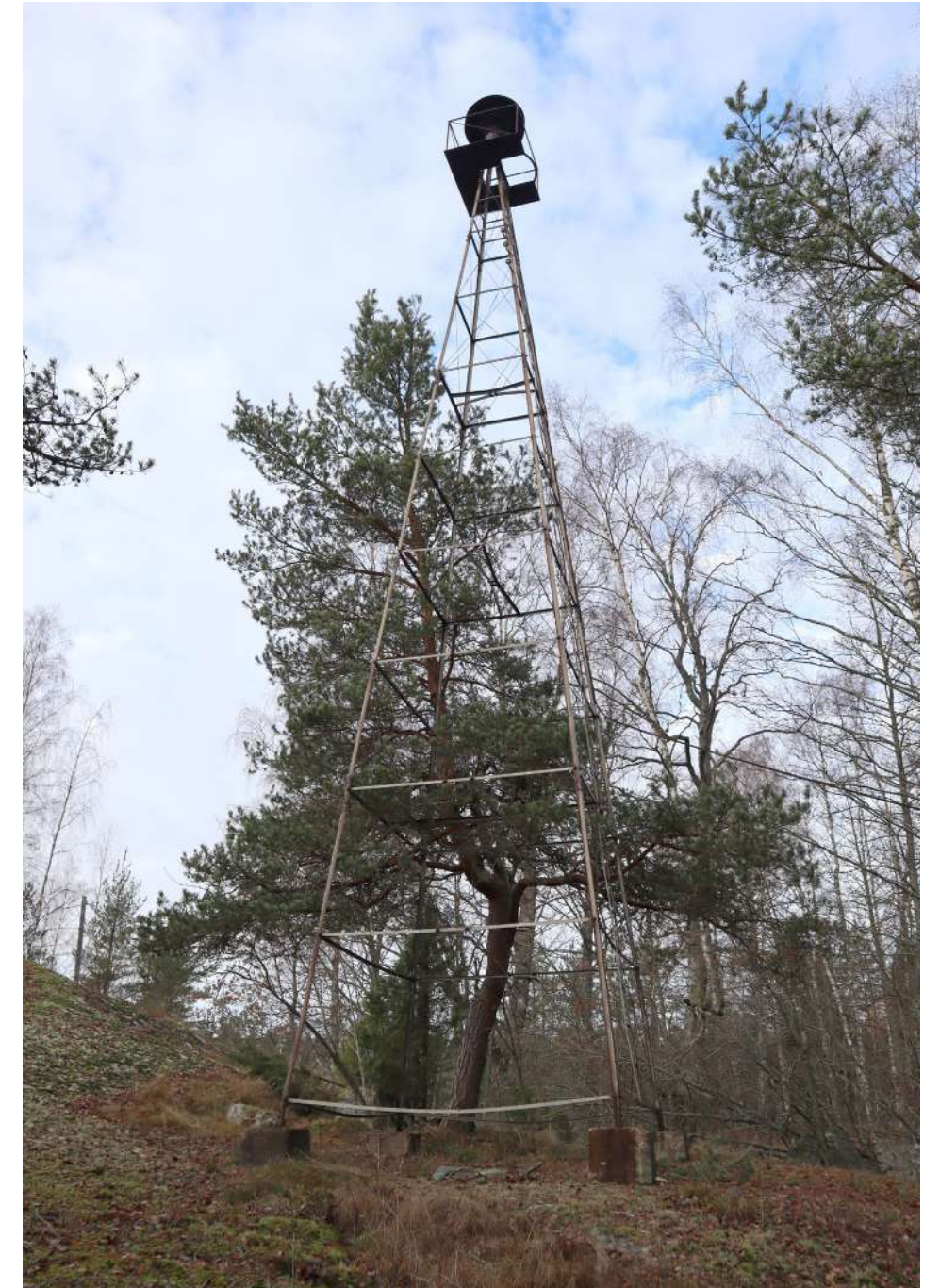
Pajan takana kalliolla seisova teräsrakenteinen merkki- tai havaintotorni. Torniin ylätasanteelle johtaa tikapuut.
