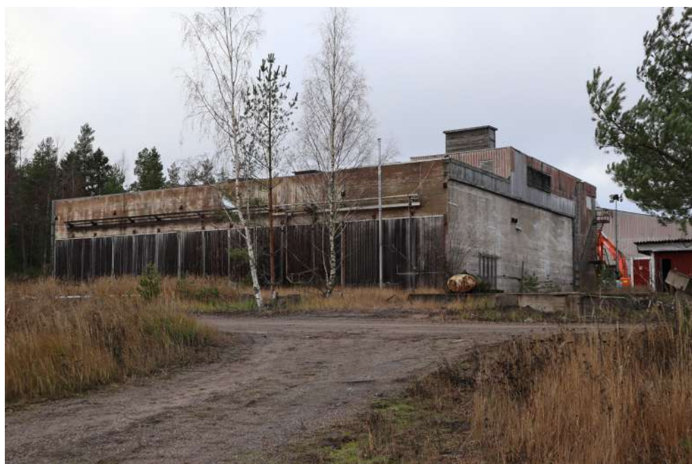
Vuonna 1971 valmistuneen betonirakenteisen kuivaamon vierellä sijainneista laajennuksista on ainoastaan betonisokkeli jäljellä.
