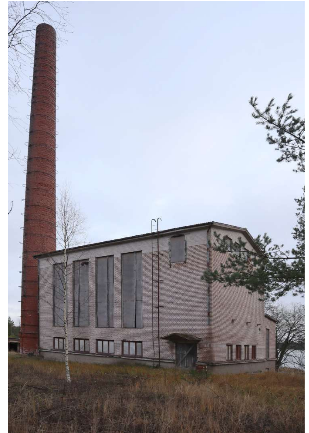
Mantereen puoleisella pitkällä sivulla on neljä korkea ikkunakenttää, joiden alapuolella toisen kerrostason matalammat ikkunat. Sisäänkäynnin päällä on teräksinen lippakatos ja ylimmällä kerrostasanteella haalausovet. Polttoaineena käytetyn sahajätteen syöttö on tapahtunut tältä sivulta.
