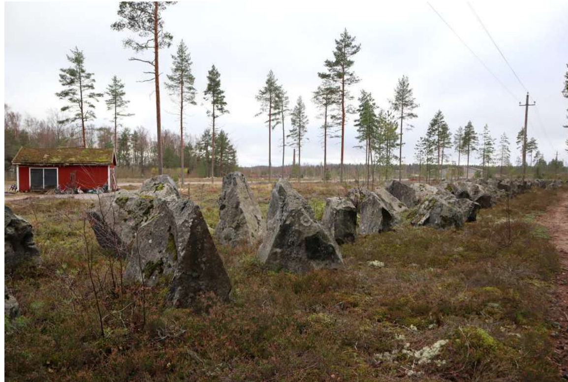
Panssarieste on rakennettu kahteen rinnakkaiseen riviin sijoitetuista suurista teräväkärkisistä kivilohkareista. Näkymä Kontoretin taustalta länteen.
