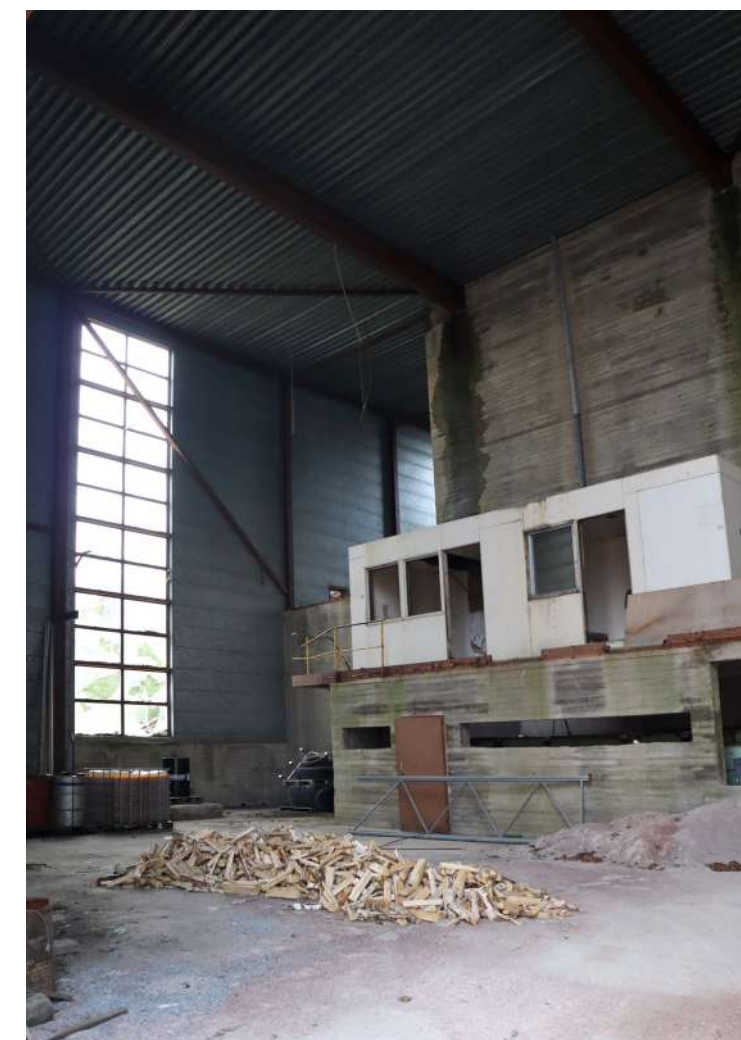
Näkymä lämpökeskuksen sisätilasta, lounaissivulla on korkea ikkuna.
