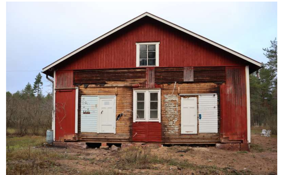
Rakennuksen eteläpäädystä on purettu kuistit.
