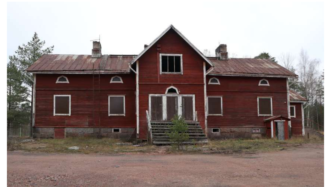
Pihajulkisivun keskellä on korkea kuisti johon oletettavasti liittyy sisäänkäynnit myös yläkerroksen asuntoihin. Oikeassa reunassa näkyvän pienen kuistin kautta on kulku kellarisiin.
