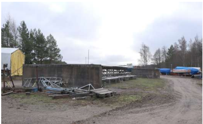
Sahan kuljetinlinjastoon liittyneitä betoniperustuksia
