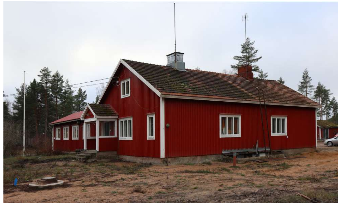
Kontoret koillisesta nähtynä.
