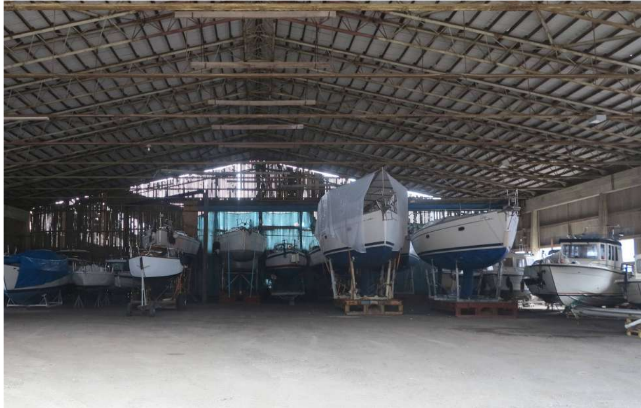
Teräsrunkoinen satulakattoinen katos, jossa Tornoverketin puunkäsittelyasema sijaitsi.
