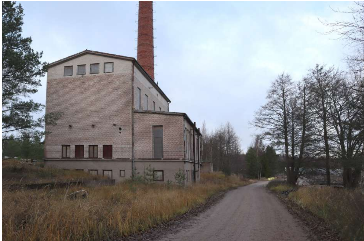
Näkymä lounaasta rantaan vievältä tieltä. Yläosan muuraus on muuta rakennusta vaaleampi, alkuperäisten suunnitelmien mukaan yläosa muurattiin kapein 1 cm korkuisin värjäämättömin saumoin ja alaosa värjäytyi 2,5 cm korkuisin saumoin.
