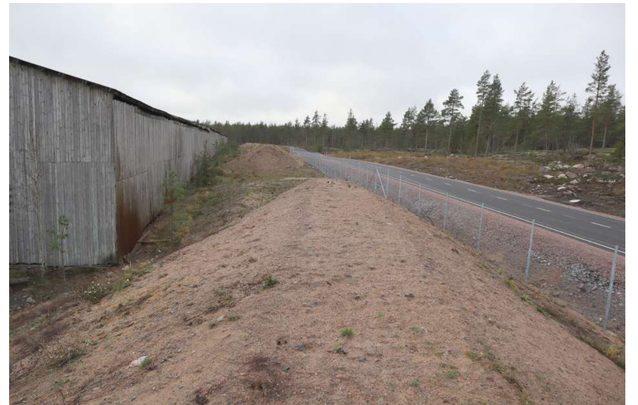
Alueen luoteisreunaan uuden tien viereen rakennettu maavalli ja lautavarastojen pitkä taustaseinä.
