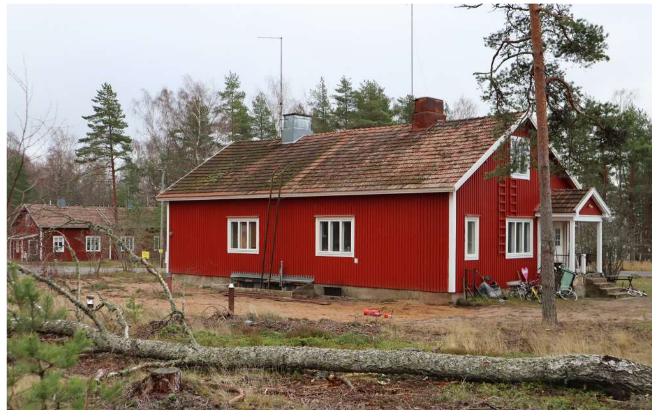
Rakennuksen pohjoissivu ja länsipäädyn kuisti. Taustalla näkyy Lustigkullan rakennus.
