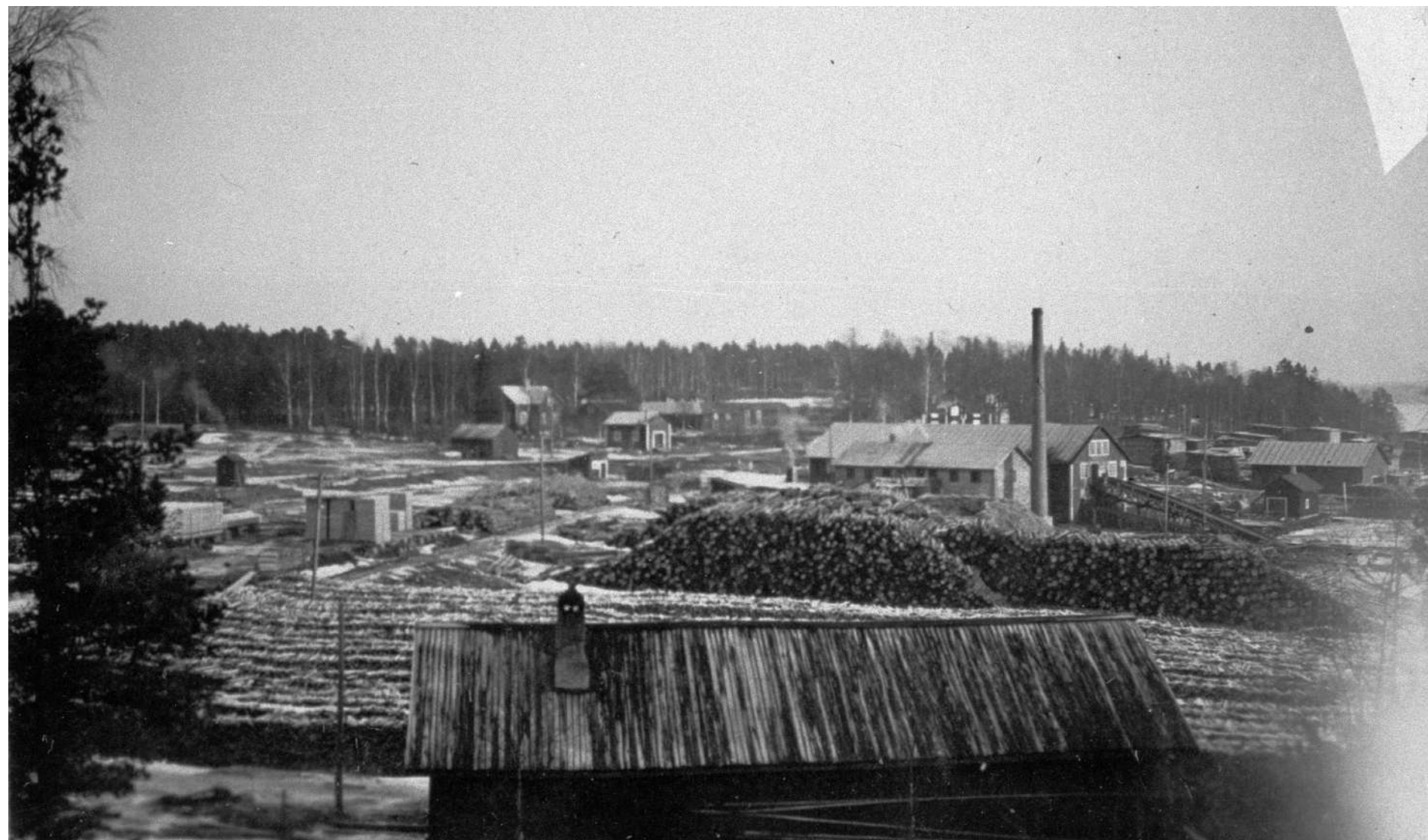
Saha-alue 1900-luvun alussa. Tukkipinojen takana näkyy ensimmäinen saharakennus ja sen vierellä tiilirakenteinen höyryvoimalaitos savupiippuineen. Taustalla metsän reunassa on sahatyöntekijöiden asuinrakennuksia talousrakennuksineen. Edustalla näkyvä rakennus on ilmeisesti ensimmäinen paja. Suunnilleen samalle paikalle kallion reunaan rakennettiin vuonna 1948 uusi paja. SLS arkisto 1642_1214 Skogby sågsamhälle.
