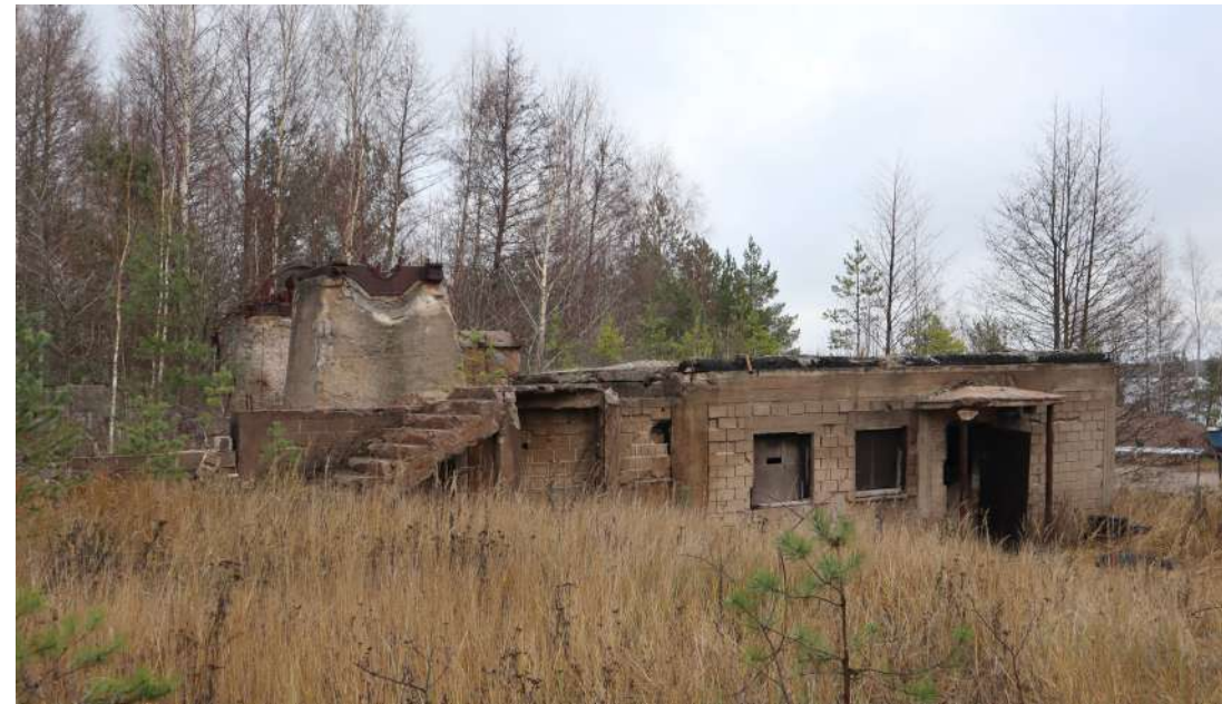
Vuonna 2005 tulipalossa tuhoutuneen saharakennuksen jäljiltä on säilynyt kalkkihiekkatilirakenteisen kellarikerroksen osa ja siihen liittyneen sisäänkäynnin teräskatos.
