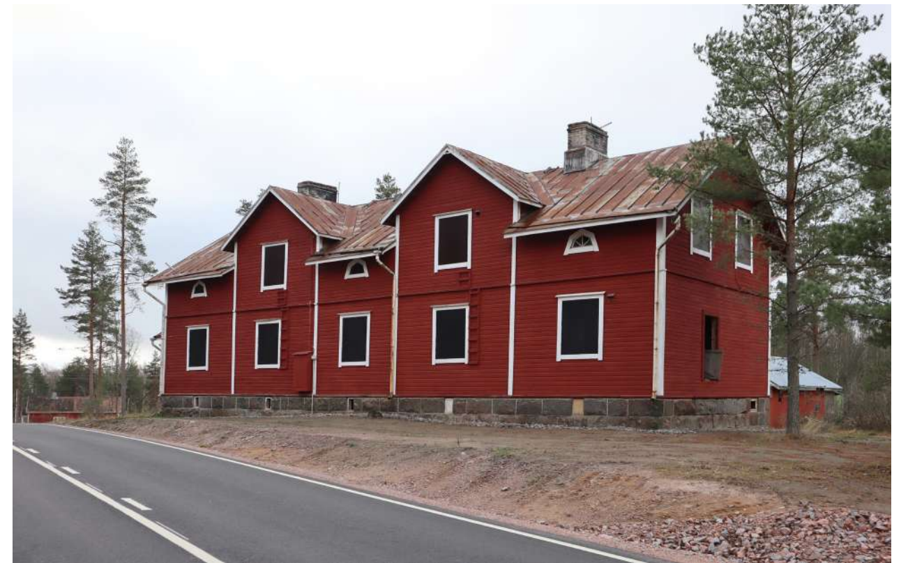
Alueen ainoa kaksikerroksinen työväen asuinrakennus on Skogbyntien kyläkuvassa hallitseva ja muodostaa porttirakennuksen alueelle saavuttaessa. Tien rakentamisen ja kasvillisuuden poistamisen seurauksena on ympäristö nykyilmeeltään karu.
