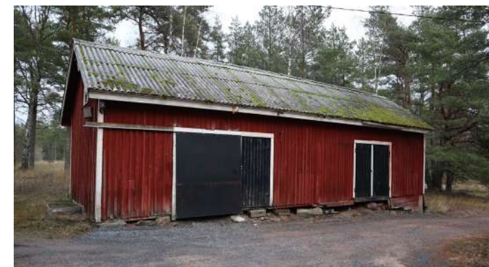
Päärakennuksen eteläpuolella sijaitseva piharakennus.
