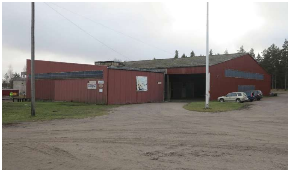
Peltiverhoiltu satulakattoinen korjaamo myöhempine laajennuksineen.
