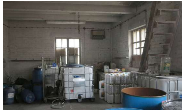
Varastotilan sisäseinät ovat kalkitut. Vasemmalla nousee tikkaat ullakolle.
