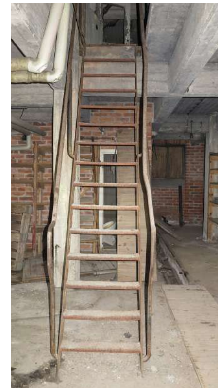
Pohjakerroksesta nousevat kapea teräsportaat. Kuvassa näkyy myös välipohjan palkkirunko.
