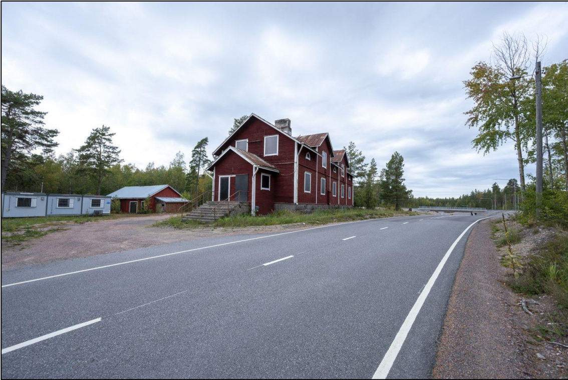
Kuva 11. Harparskog-linja 25:n muinaisjäännösalueella oleva rakennus. Pihalla ei havaittu merkkejä puolustusrakenteista, mutta sen pohjois- ja eteläpuolella on juoksuhauda. Kuva kaakosta. (AKDG7376:19)
