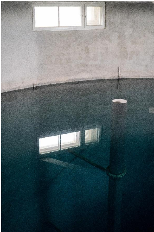
Vattenytan i vattenbehållaren i Karis vattentorn
