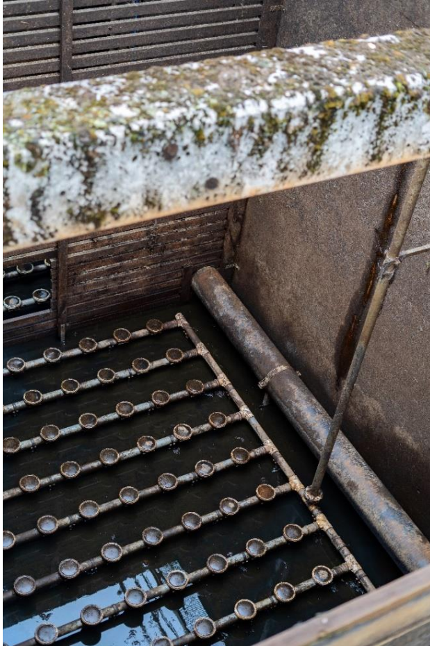
En av Skeppsholmens reningsverks processbassäng tömd under mellanväggsbygget
