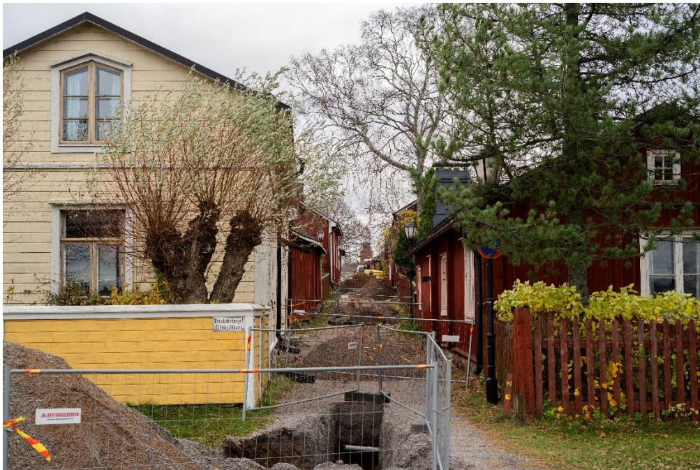
Sanering av Linväregatan, Ekenäs
