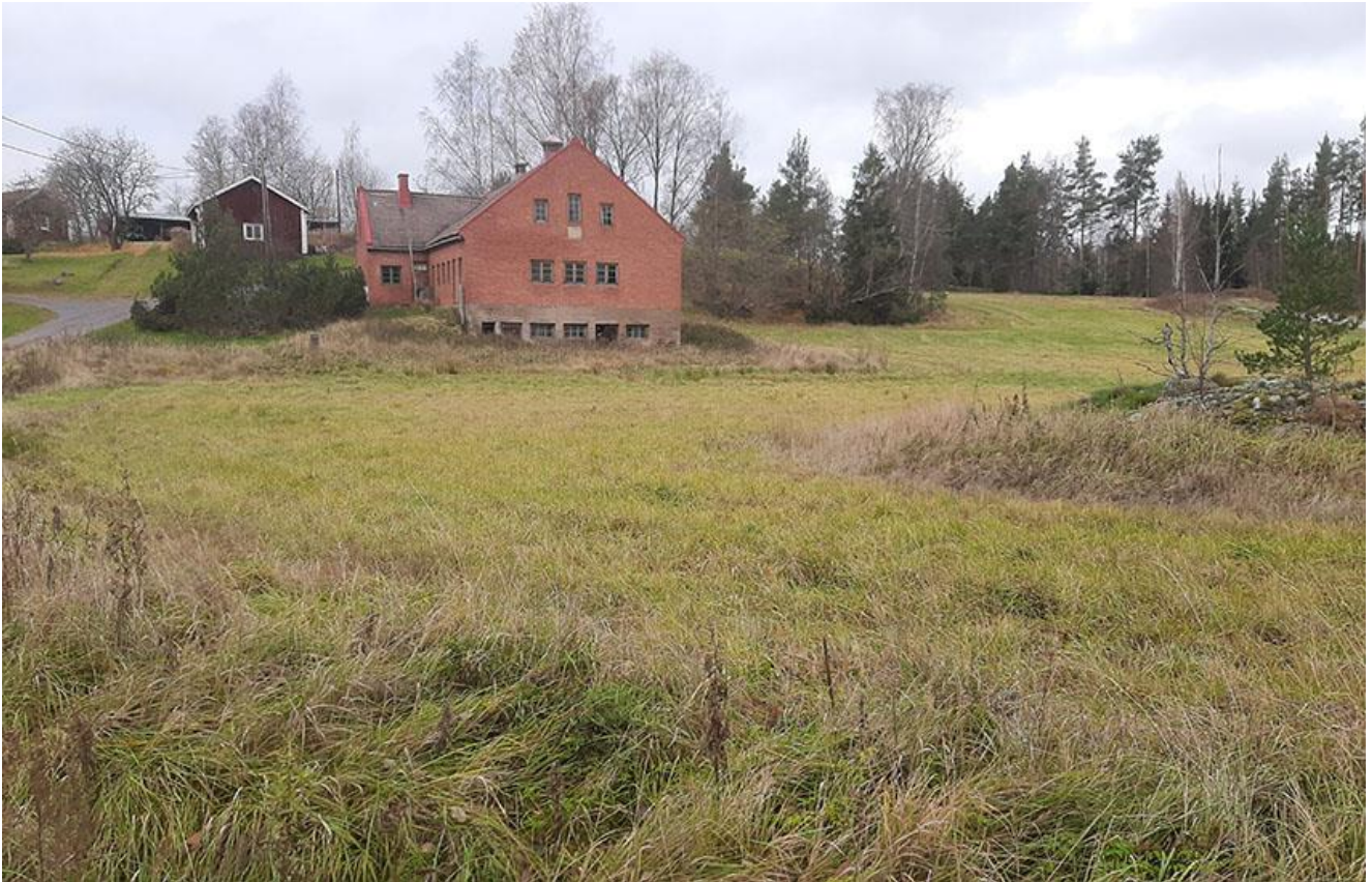
Bild 2. Ladugården är byggd av brända röda tegel, taket av betongtegel.
