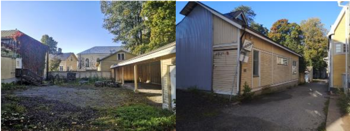
Suunnittelualue 2021, avoin rakentamaton alue kiinteistöllä. Oikealla rakennus joka on ollut osa päivittäistavarakauppaa (Sepänkadun suuntaan).
