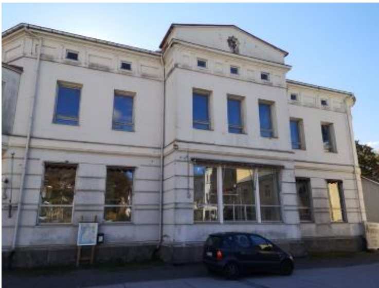
Lydmanin talo ennen julkisivun restaurointia (2021), Raatihuoneentorin suuntaan.
