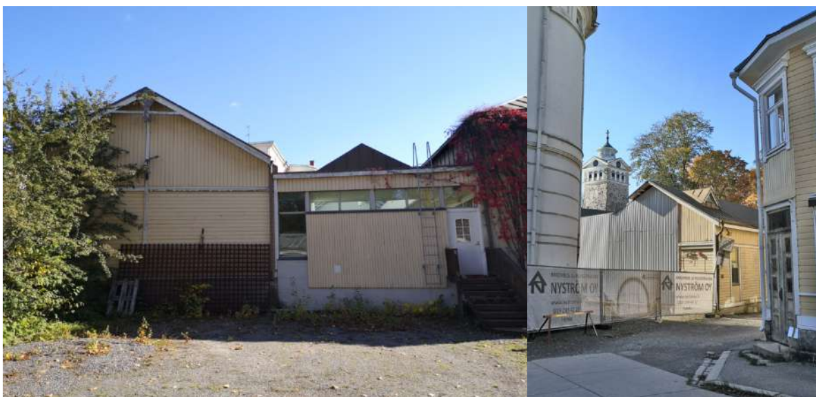
Planeringsområdet 2021, fasad mot innergården, till höger en vy från hörnet av Rådhusorget med Lydmanska huset till vänster
