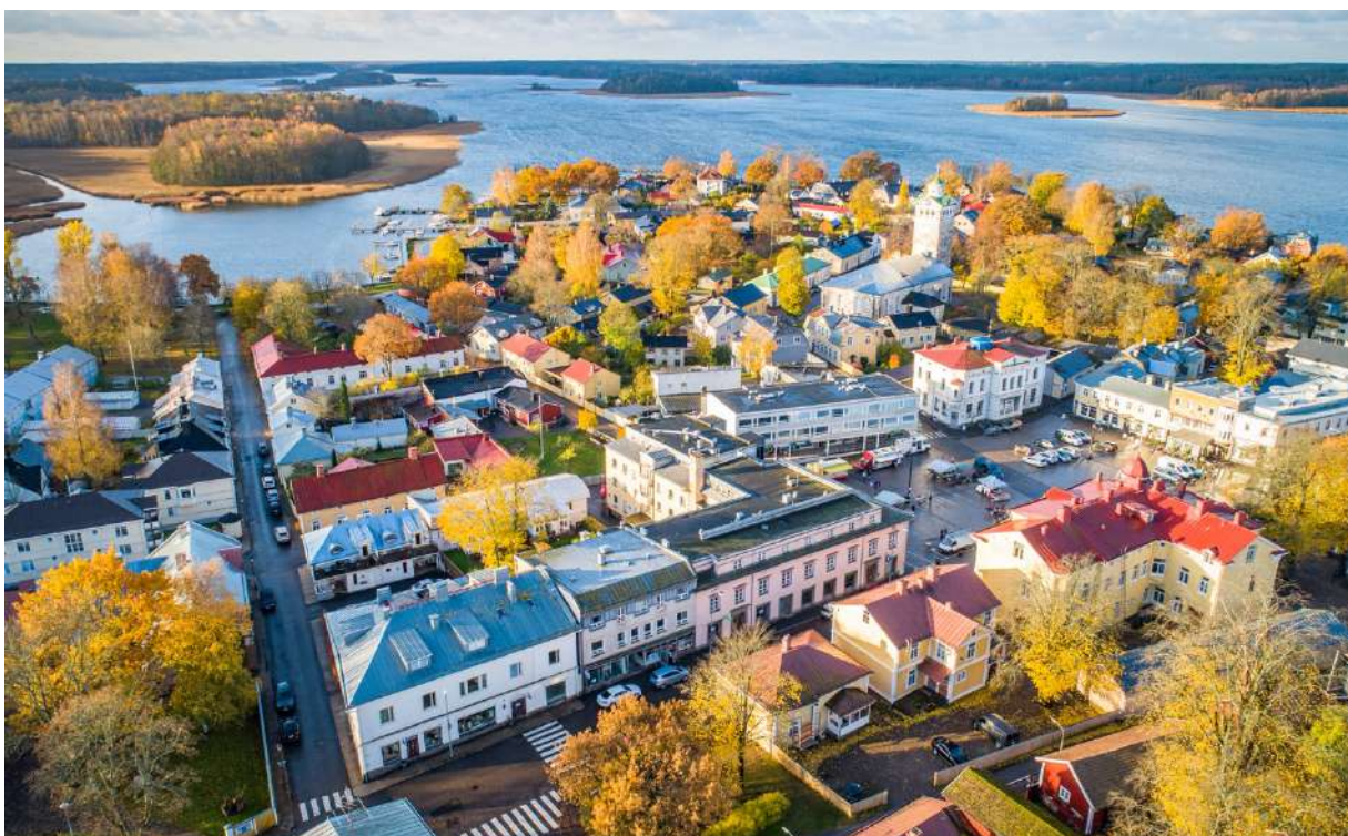
Flygfoto över Ekenäs centrum, Rådhusstorget till höger i bilden. Foto Multifoto Oy
