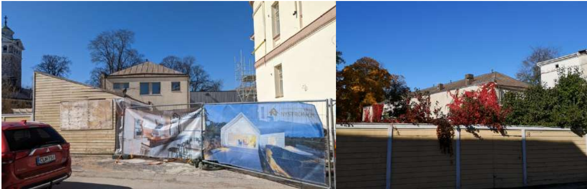
Planeringsområdet, fasad mot Stora Kyrkogatan (2023), till höger del av byggnaden på tomtgränsen mot söder
