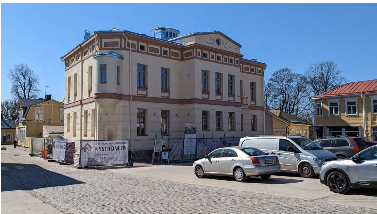
Den sr-1 märkta bygganden Lydmanska huset i april 2023
