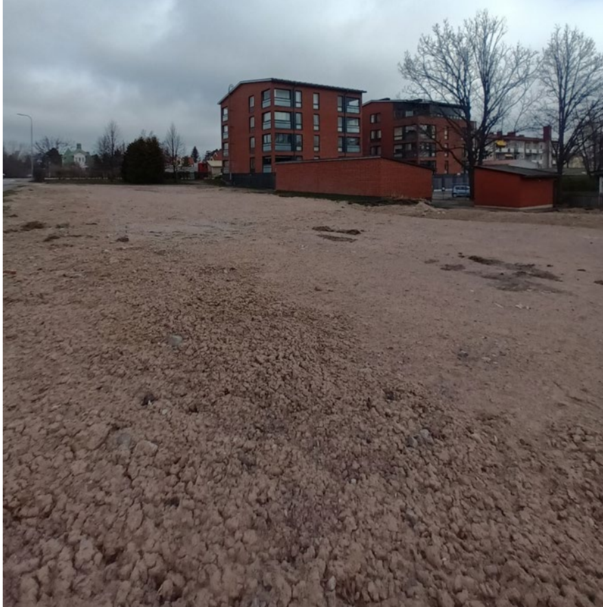
Kuva 3. Painotalo purettiin syksyllä 2022, kaava-alueelle jäänyt jätekatos näkyy kuvan oikeassa reunassa. Maanpinta ei ole enää päällystetty asfaltilla.
