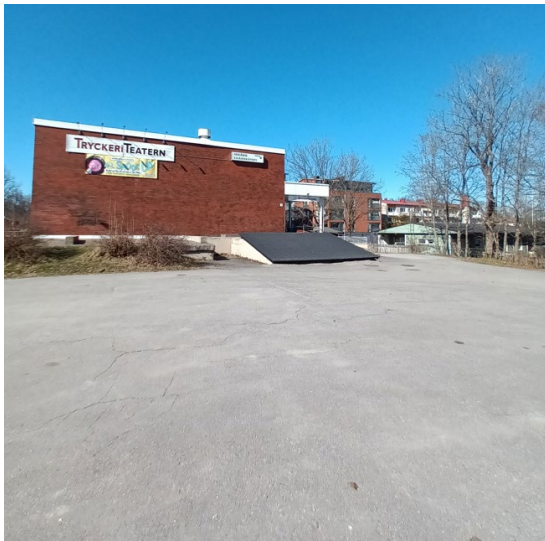
Kuva 2. Kaava-alue oli rakennettu ja suurelta osin päällystetty. Alueella oli aikaisemmin vanha painotalo.
