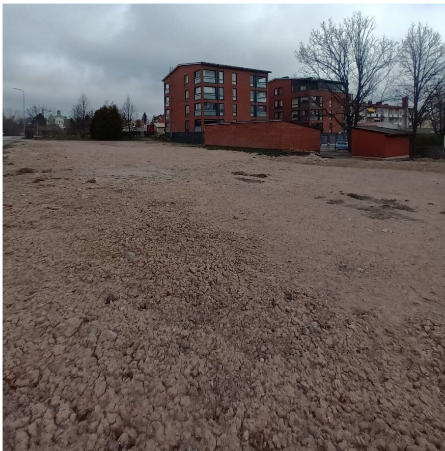
Bild 3. Tryckeribygnaden revs hösten 2022, avfallstaket som står kvar på planområdet kan ses längst till höger på bilden. Marken är inte längre asfalterad.
