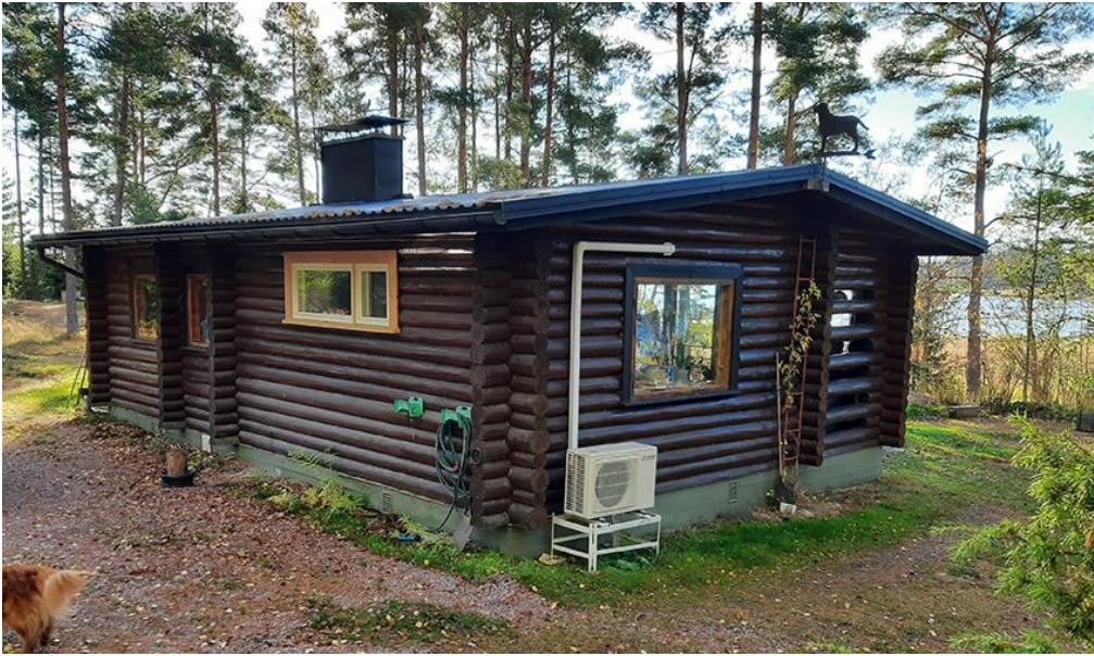
Kuva 7. Korttelin 2 rakennuspaikalla 2 oleva vapaa-ajan mökki on rakennettu v. 1969, rakennuslupa myönnetty 24.6.1969.
