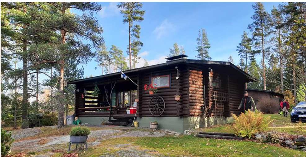
Kuva 3. Korttelin 1 rakennuspaikalla 2 oleva vapaa-ajan mökki on rakennettu v. 1969. Rakennuslupa myönnetty 24.6.1969. Voimassa olevan ranta-asemakaavan aluemerkinnot on M, maatilatalouden alue.
