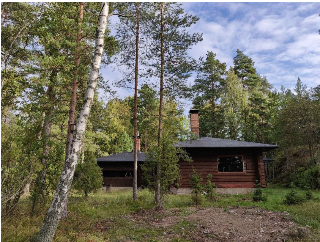
KUVA 36 Eteläjulkisivuja. Kuvattu vuonna 2019, ennen vuoden 2020 räystäskouru- ja syöksytoviremonttia.
