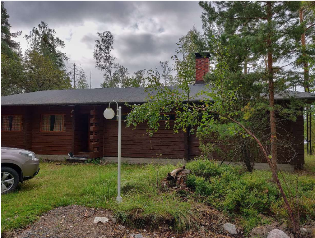
KUVA 32 Rakennuksen pohjoisjulkisivu. Kuvattu vuonna 2019, ennen vuoden 2020 räystäskouru- ja syöksytorviremonttia.
