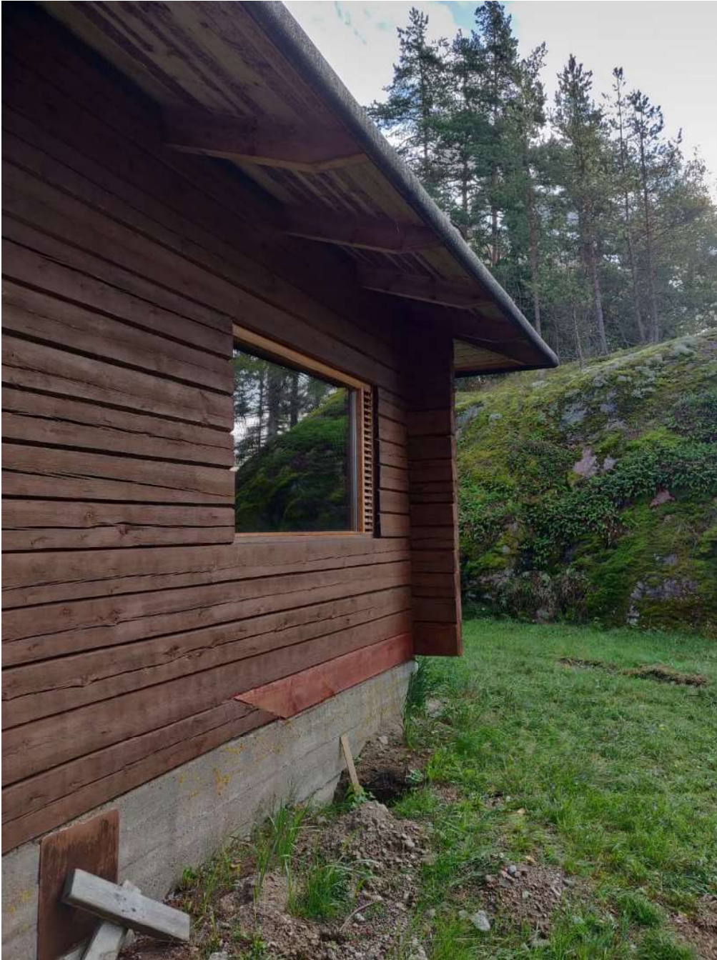
KUVA 22 Rakennuksen eteläpääty/kaakkoiskulma. Kuvassa näkyy korjattu alahirsi.
