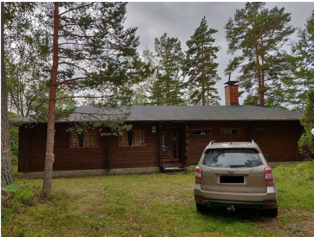
KUVA 33 Rakennuksen pohjoisjulkisivu. Kuvattu vuonna 2019, ennen vuoden 2020 räystäskouru- ja syöksytorviremonttia.
