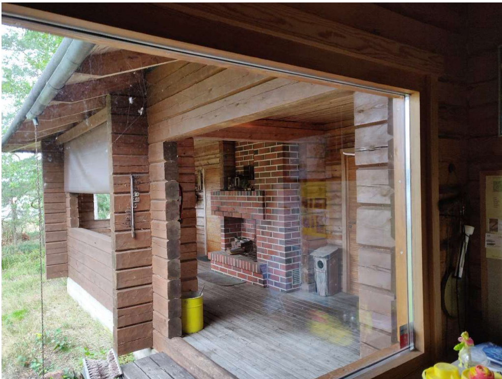
KUVA 64 Saunan terassi takkoineen. Kuvattu vuonna 2019, ennen vuoden 2020 räystäskouru- ja syöksyturviremonttia. Oikealta pilkistää ovi pukuhuoneeseen.
