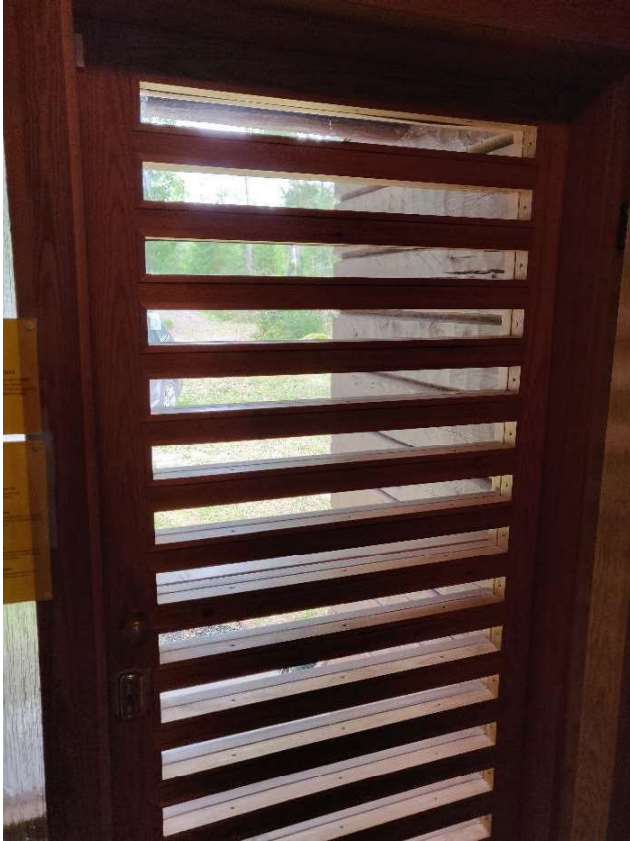
KUVA 42 Pääoven detaljiikkaa. Näkymä ulos pohjoiseen.
