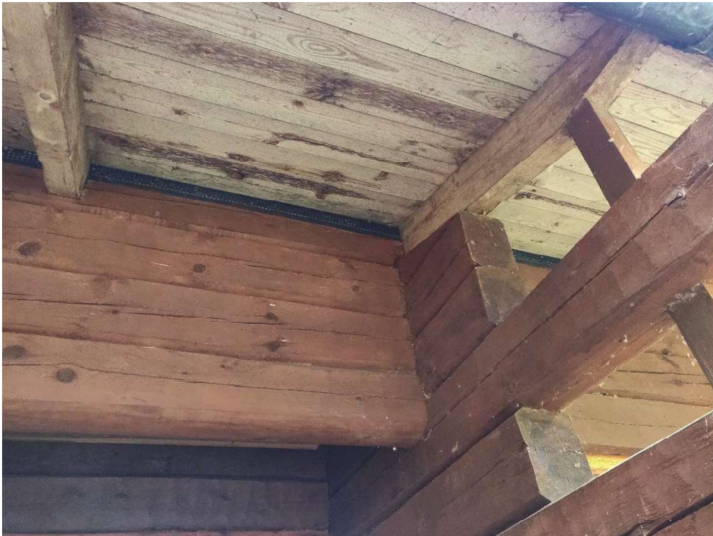
KUVA 40 Pääoven oikealle puolelle sijoittuvaa hirsideteljiikkaa.
