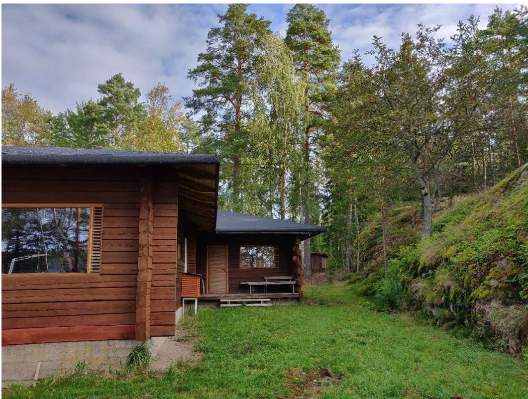
KUVA 35 Eteläjulkisivuja, vasemmanpuoleinen ikkuna on tuvan ikkuna ja oikealla päämakuuhuoneen ikkuna. Oikeassa reunassa kallioalue. Kuvattu vuonna 2019, ennen vuoden 2020 räystäskouru- ja syöksyturviremonttia.
