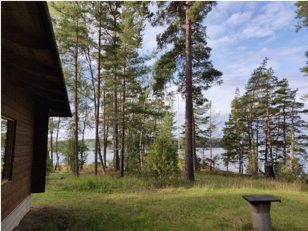
KUVA 28 Kuva etelään. Vasemmalla rakennuksen länsijulkisivua ja lounaskulmaa. Kuvattu vuonna 2019, ennen vuoden 2020 räystäskouru- ja syöksytöremonttia.
