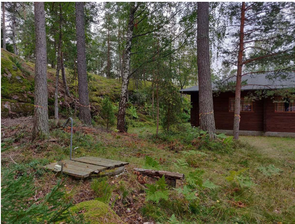
KUVA 25 Rakennuksen pohjoisjulkisivua ja sen itäpuolelle sijoittuva kallio. Etualalla syväporakaivo, josta painevesi tulee rakennukseen.
