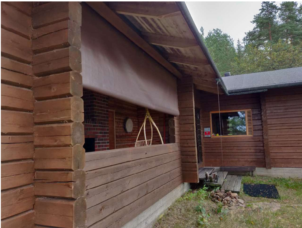
KUVA 38 Saunan terassi. Kuvattu vuonna 2019, ennen vuoden 2020 räystäskouru- ja syöksytoviremonttia.
