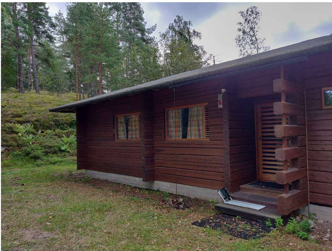
KUVA 34 Rakennuksen pohjoisjulkisivua ja pääovi. Kuvattu vuonna 2019, ennen vuoden 2020 räystäskouru- ja syöksyturviremonttia.
