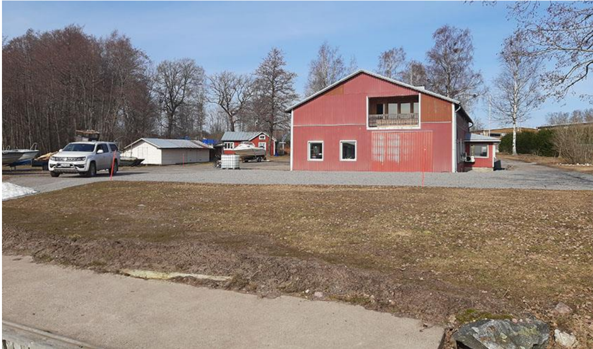
Korttelin 9351 tontilla 1 oleva hallirakennus konttoreineen. Rakennuksen ylemmässä kerroksessa on asunto.
