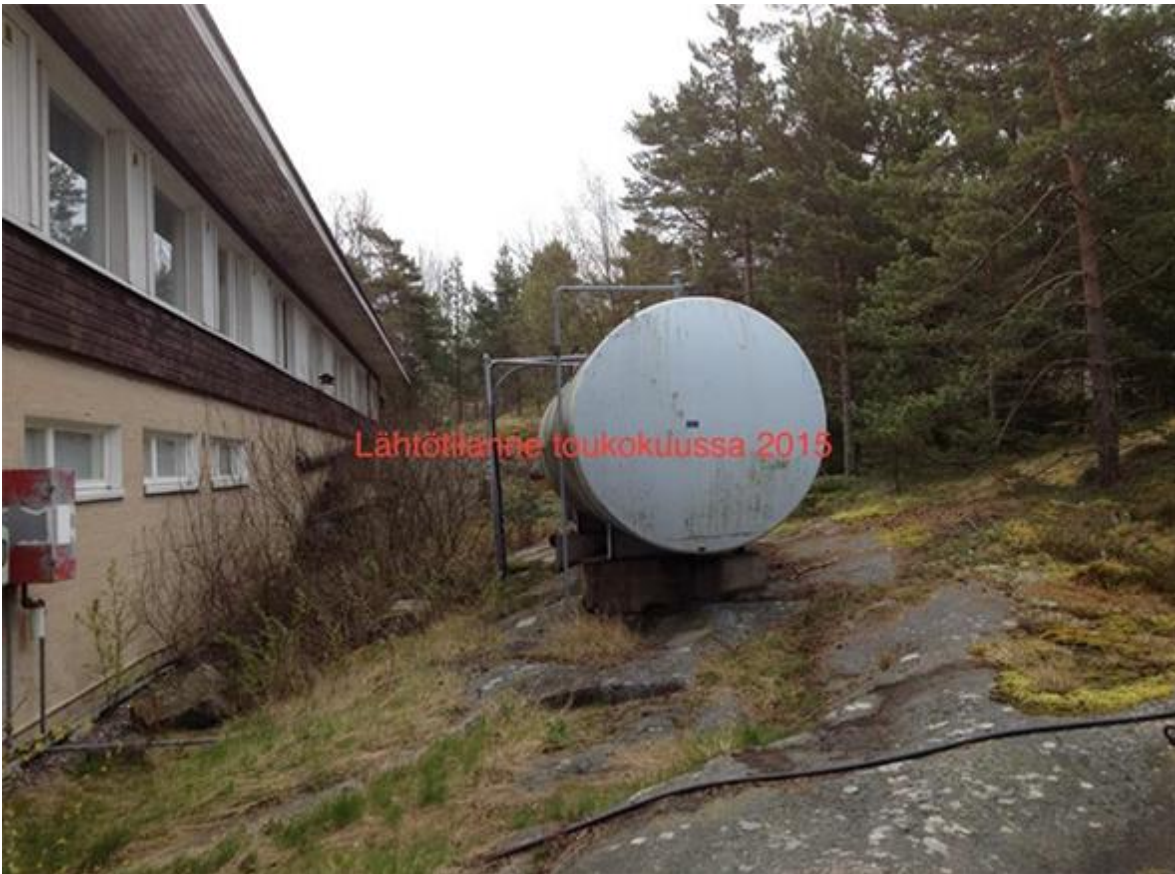
Asemarakennuksen eteläjulkisivu sekä maanpäällinen öljysäiliö ennen peruskorjausta.
