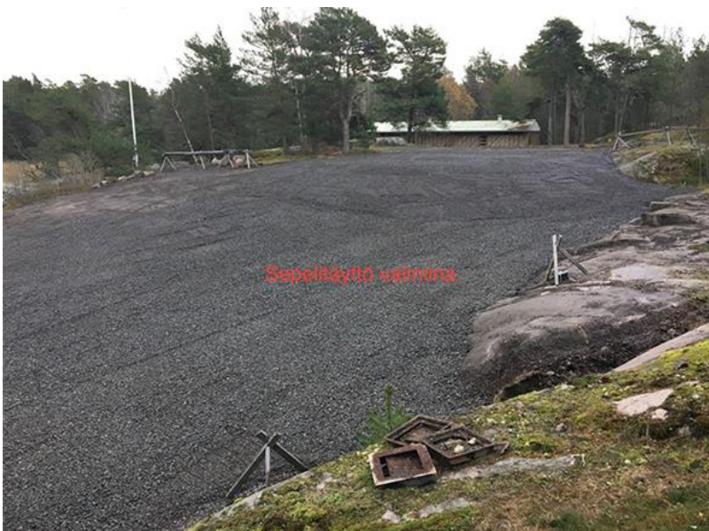
Maaperän saneeraus valmistumassa.
