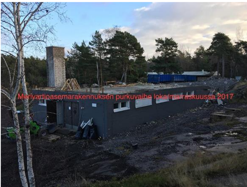
Saneeraushanke aloitettiin purkamalla asemarakennus ja poistamalla sen takana ollut öljysäiliö.
