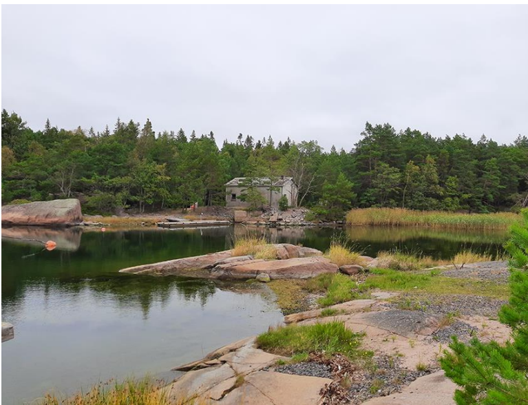
Poukaman pohjoisrannassa oleva Metsähallituksen rakennus on varastokäytössä.
