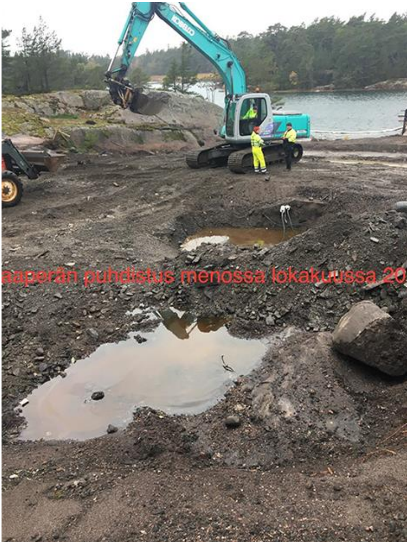
Saastunut maa-aines kaivettiin pois ja kuljetettiin mantereelle puhdistuslaitokseen.
