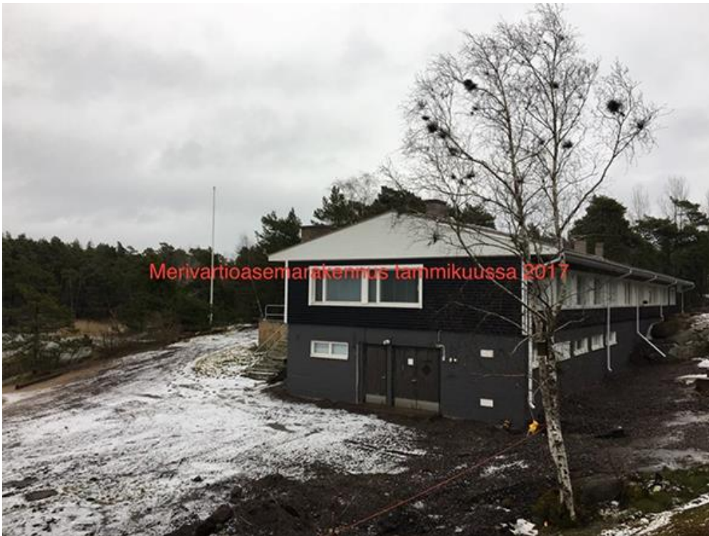
Asemarakennuksen julkisivu etelään ja länteen peruskorjauksen jälkeen.
