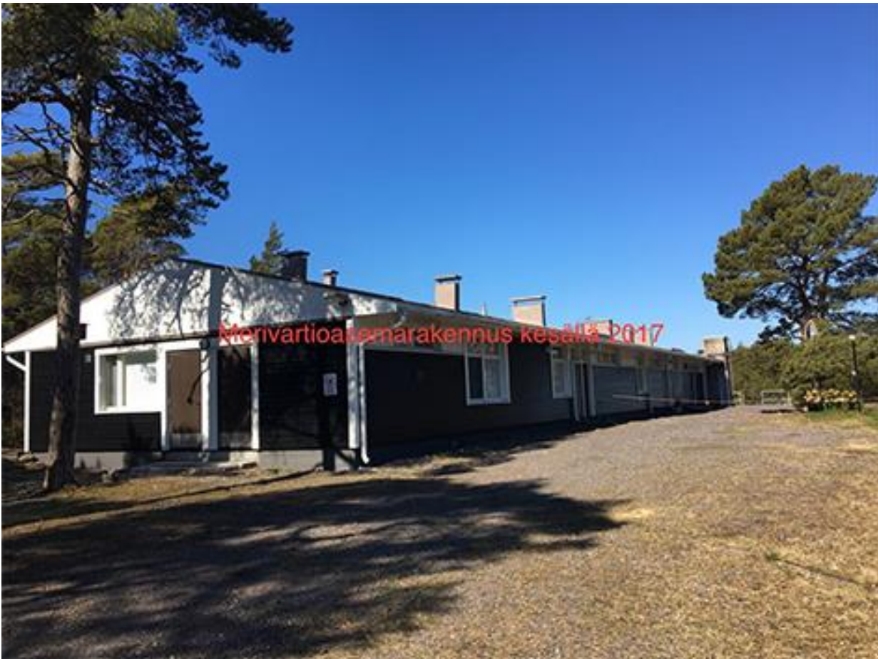
Den grundrenoverad stantionsbyggnaden sommaren 2017.
