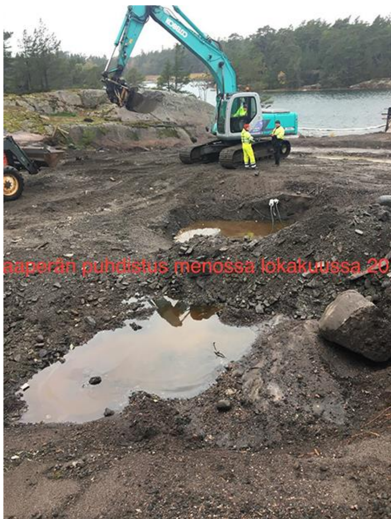
Den förorenade jorden grävdes bort och transporterades till reningsanläggning på fastlandet .
