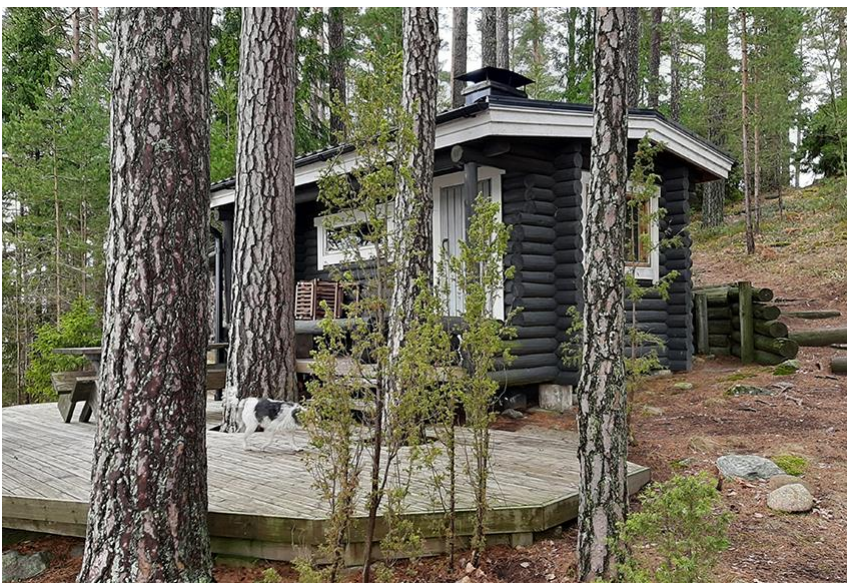
Kuvat 15-17. Korttelin 3 rakennuspaikan 3 päärakennus, sivuloma-asunto ja rantasauna.
