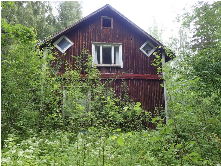
Valokuva 5. Näkymä vanhasta asuinrakennuksesta.
