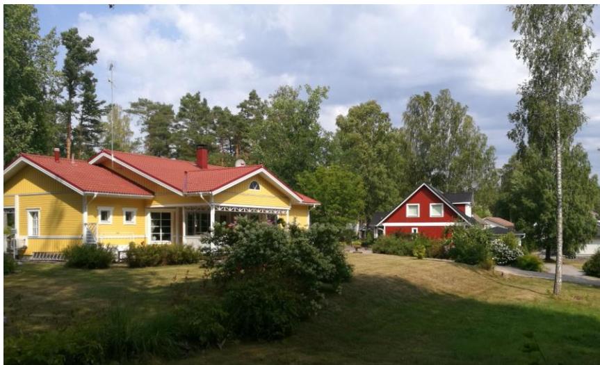
Valokuva 8. Näkymä naapuruston rakennuskannasta.
