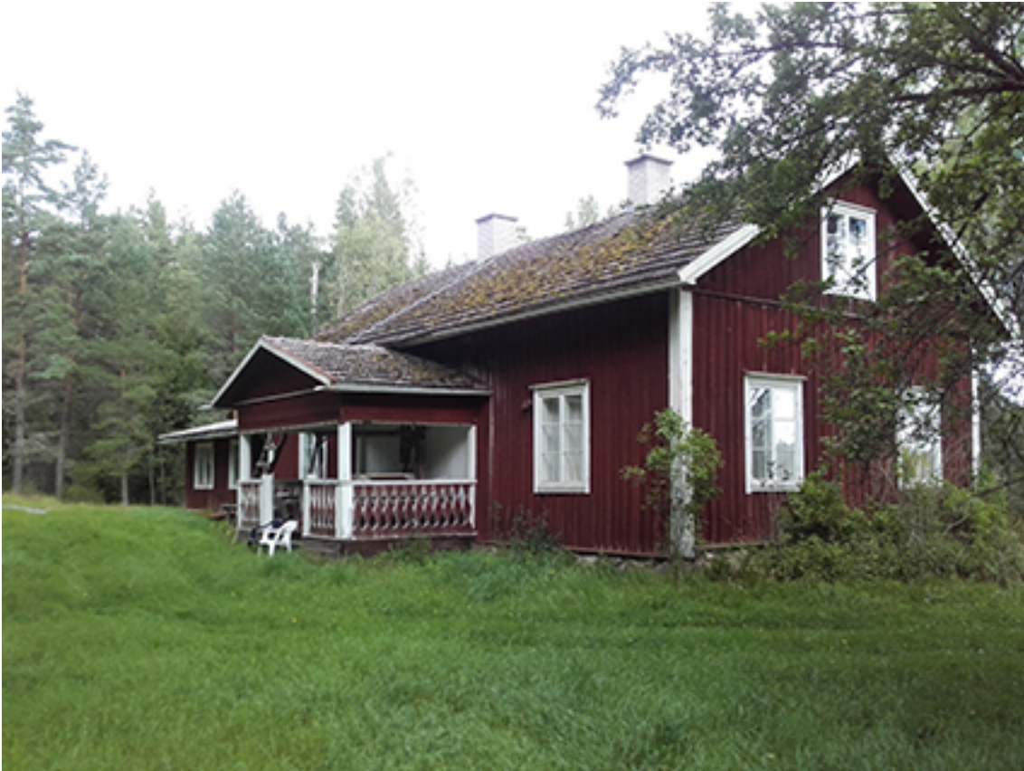
Kuva 1. Korttelin 1 päärakennus, rakennuspaikka 1.
