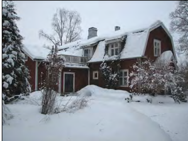
Kuva: Asuinrakennus luoteiskulmalta
