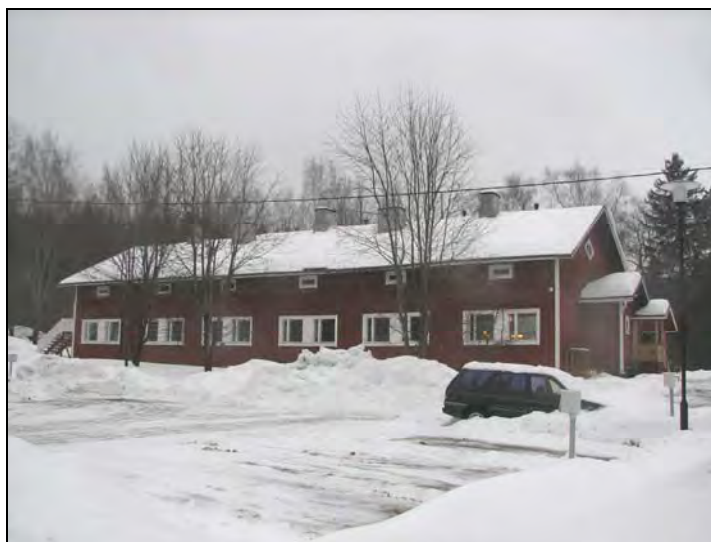
Kuva: Hakamäen eteläinen, 2000-luvulla kunnostettu asuinrakennus.
