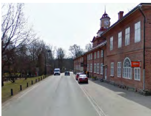
Bild 3 (vänster) Körbanan och trottoaren ligger på samma nivå. På den andra bilden (höger) har trottoaren avgränsats genom höjning
