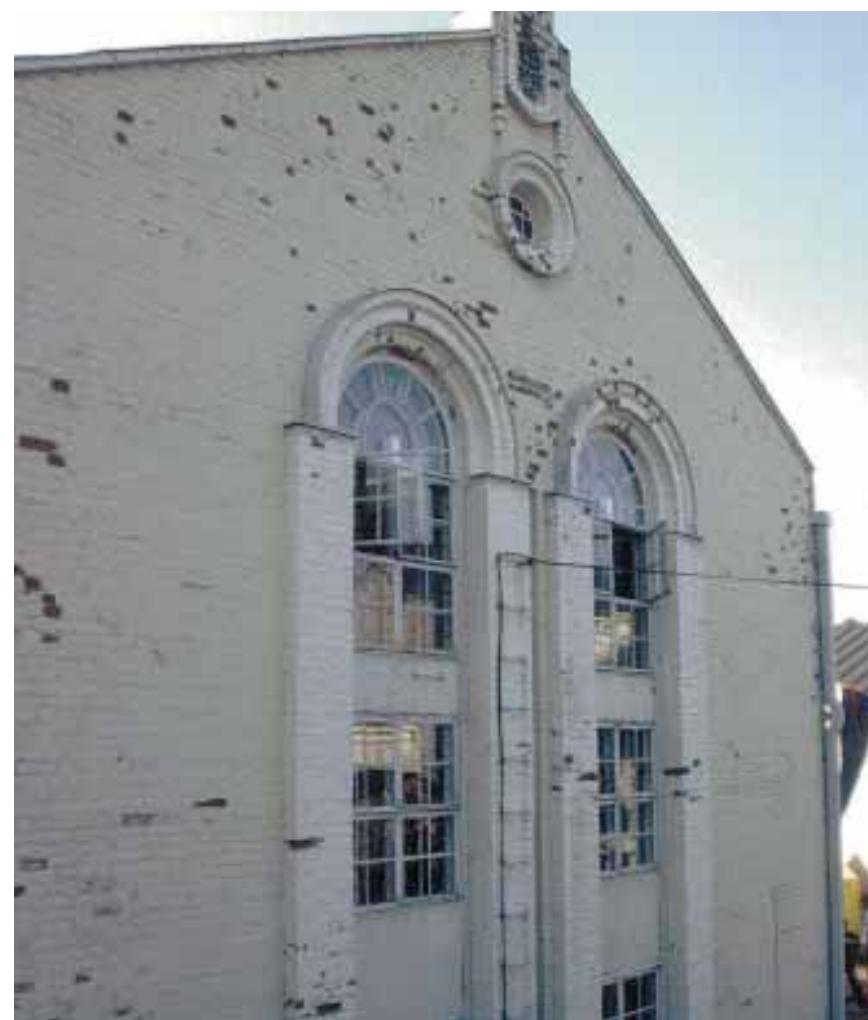
Liian tiivis maalipinta salpaa huoneilmasta poistuvan kosteuden seinärakenteeseen, joka talvisen jäätyksen seurauksena rapautuu hyvin nopeasti. Kuva Tuija Mikkonen.
