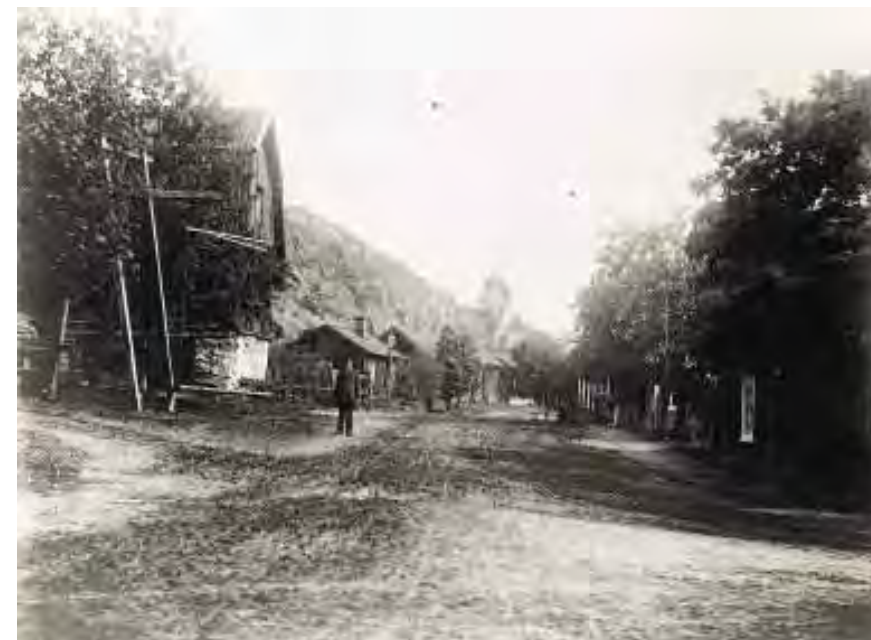
Vasarasepantie 1800-luvun lopussa Suuren Rantatien ja Raaseborgintien risteyksestä katsottuna. Tie on sorapintainen, keskellä on ajoneuvojen urat ja reunamilla polut jalankulkijoille. Vasemmalla näkyvän miehen takana on vanha lyhtypylväs. Yksi sellainen on säilynyt ruukin varastoissa ja voitaisiin pystyttää mahdollisesti perustettavalle museotieosuudelle. Kuva Museovirasto.
