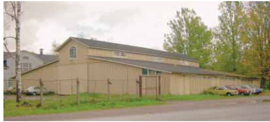
Maan pinta on noussut varaston seinustalla. Seinän vieressä jatkuvasti seisovat autot estävät säännölliset huoltotyöt.
