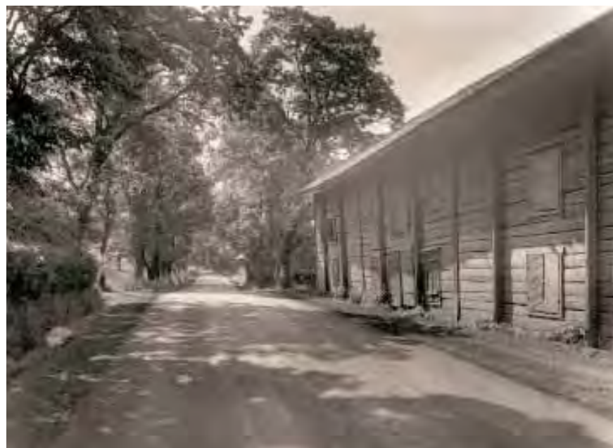
Puistotie vuonna 1969. Pojoladan on vielä tien tasossa niin, että ovet pystyy avaamaan. Nykyään ovet ovat puoli metriä syvällä penkan alapuolella. Museovirasto / P-O Welin.
