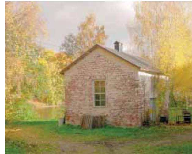
T 15 vanha vesivoimalaitos, nykyinen paja. Puut kasvavat liian lähellä seinustaa.
