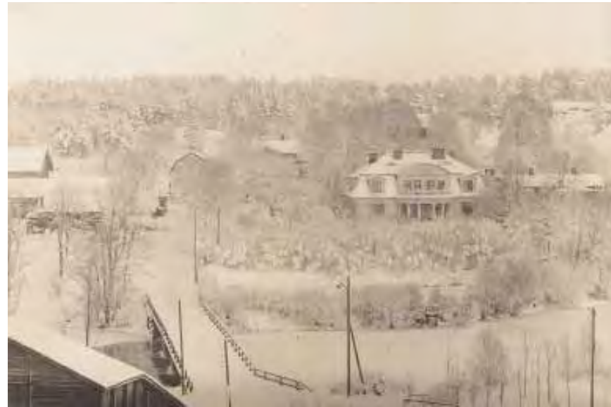
Isännöitsijän talo radan suunnasta. Kuvassa näkyy kasvimaan pensasaita, puutarhaa rajaava syreeniaita ja rannassa ollut laituri. Vasemmalla hiilivaraston kulmaa. Kuva on oletettavasti 1910-luvulta. Fiskars-yhtiön arkisto.
