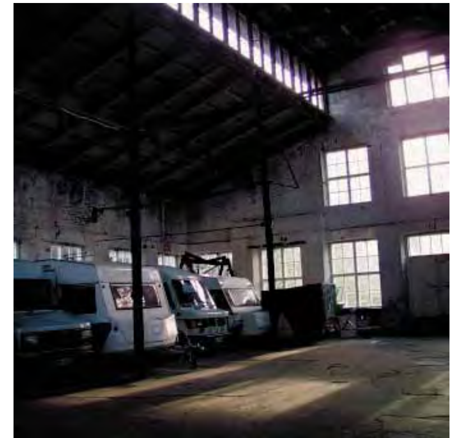
Varastokäyttö ei vahingoita historiallisesti merkittäviä tiloja, mutta ei myös lisää niiden yleistä arvostusta.
