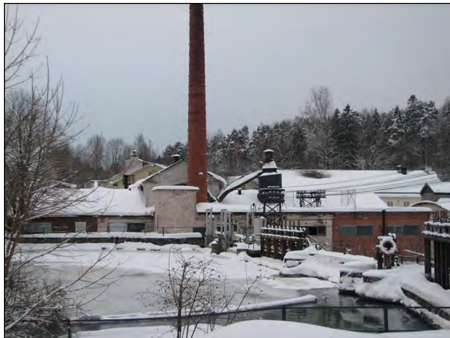
Kuva: Höyryvoimalaitos etelä- ja pohjoispuolella.
