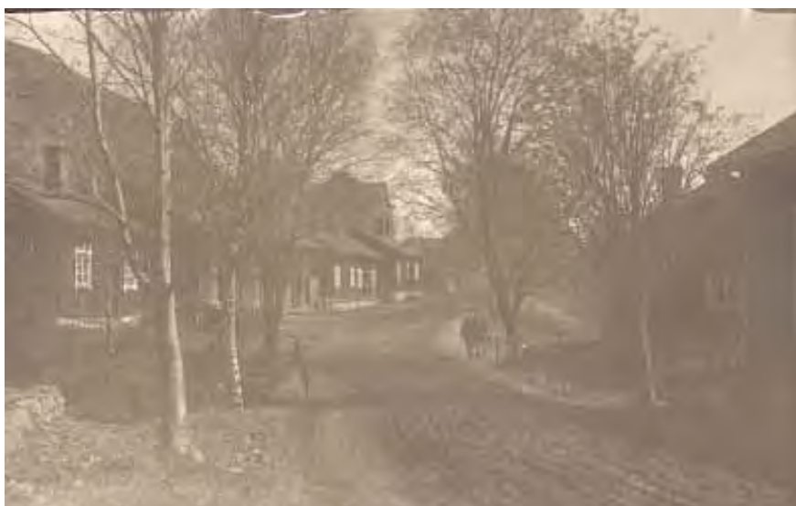
Vasarasepantie 1900-luvun alussa. Tien reunalla ei ole oja, mikä viittaa siihen, että sen alla on ajalle tyyppilliseen tapaan hyvä salaojitus. Vasemmalla näkyy kivireunusta, joka lienee osa vanhan makasiinin vieressä olevan puutarhan terassointia. Fiskars-yhtiön arkisto.
