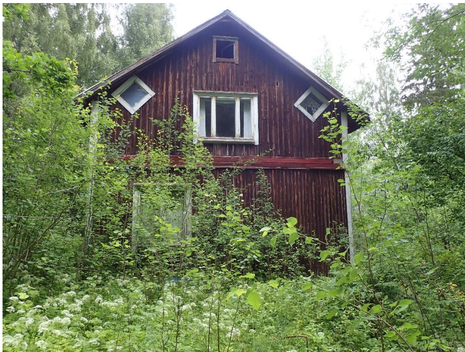
Valokuva 5. Näkymä vanhasta asuinrakennuksesta.
