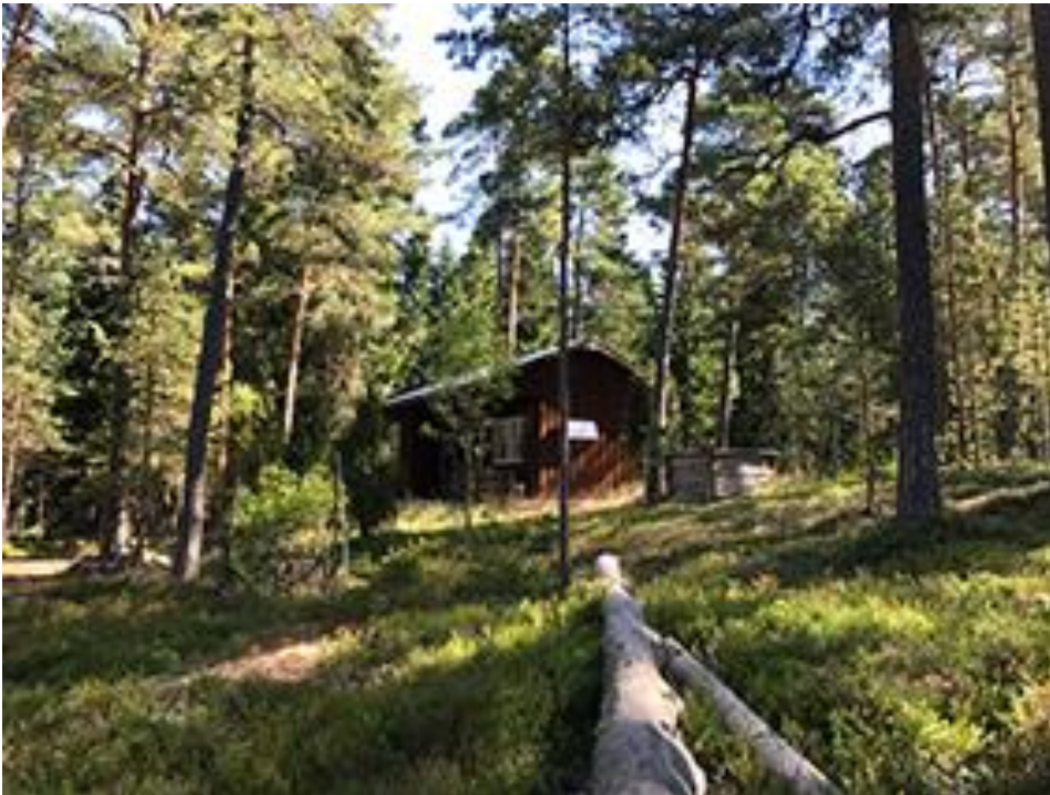
Bild 9. Strandbastun på byggnadsplats 3 i kvarter 4.
