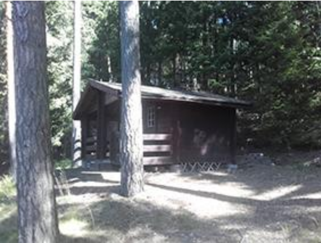
Kuva 6. Korttelin 3 rakennuspaikalla 1 oleva sauna.
