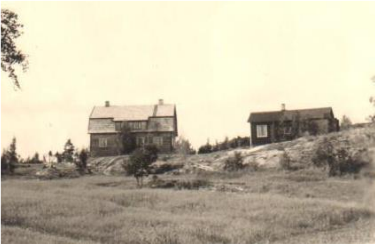
Bild 4. De nybyggda bostadshusen efter kriget, bild norrifrån.
